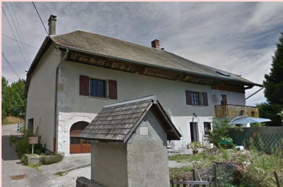
Bâtiment repéré par erreur
