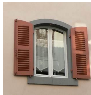
Fenêtre à un carreau unique sans vantail ; la baie n'est pas « habillée » par l'absence de partage de la menuiserie par des bois.
