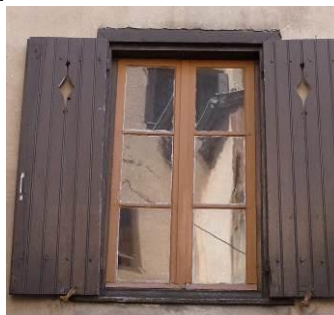
La fenêtre « à la Française » à 6 carreaux, correspond au modèle courant développé après le 17 ème siècle.
