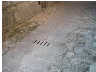
Sol des galeries
