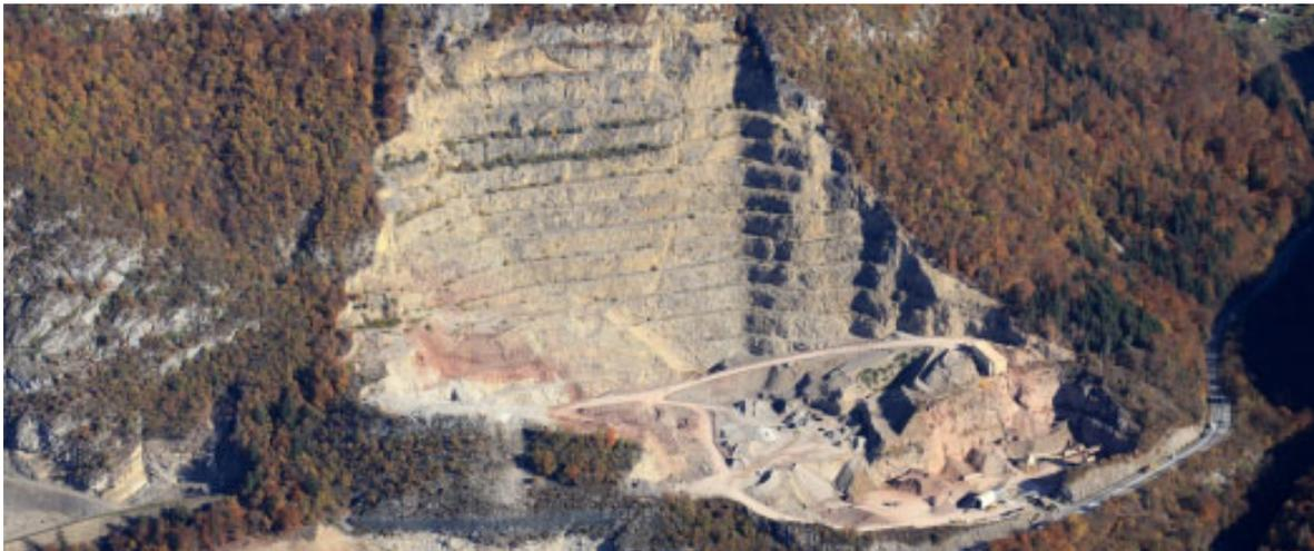
Figure 4 - Vue sur une exploitation de carrière en redan sur un versant incliné (carrière de Saint-Joire, 74).
