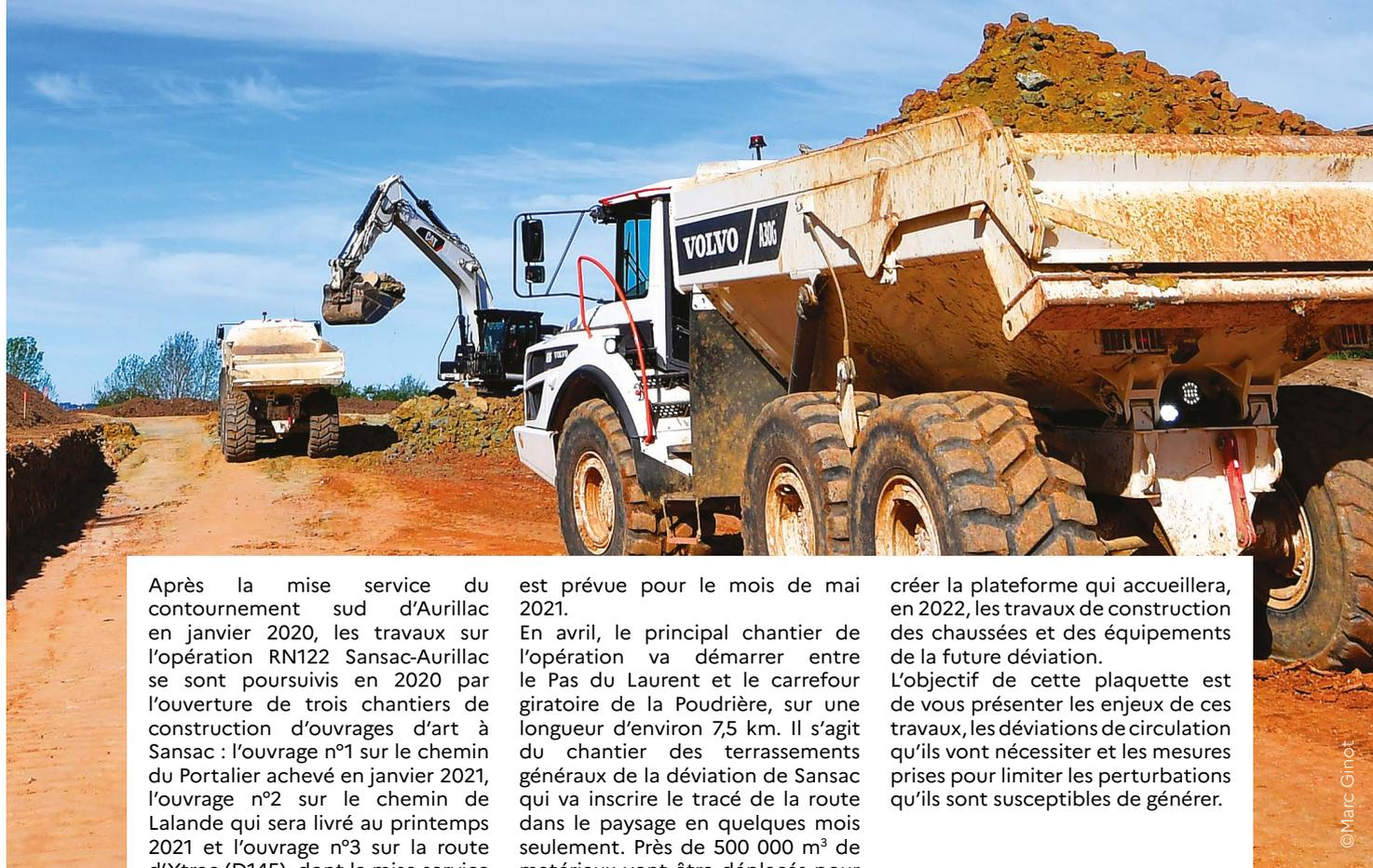
Après la mise service du contournement sud d'Aurillac en janvier 2020, les travaux sur l'opération RN122 Sansac-Aurillac se sont poursuivis en 2020 par l'ouverture de trois chantiers de construction d'ouvrages d'art à Sansac : l'ouvrage n°1 sur le chemin du Portulier achevé en janvier 2021, l'ouvrage n°2 sur le chemin de Lalande qui sera livré au printemps 2021 et l'ouvrage n°3 sur la route d'Ytrac (D145), dont la mise service
