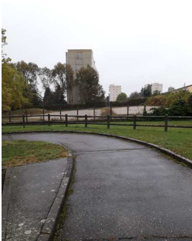
Photographie 5 : Vue sur le sud du site depuis l'ouest de la station essence
