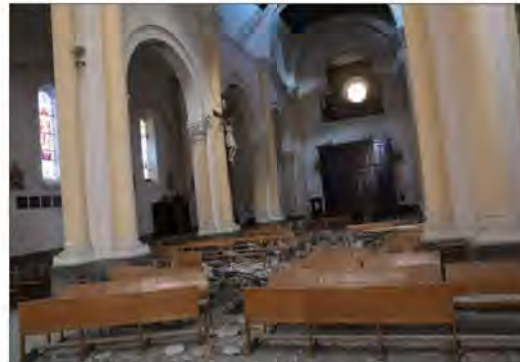
À l'intérieur de l'église du Teil complètement dévastée, rien n'a bougé. Photo Le DL/Stéphane MARC
