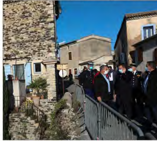
Les élus ont constaté les dégâts sur le pont de Mélas, en partie effondré. Photo Le DL/Stéphane MARC
