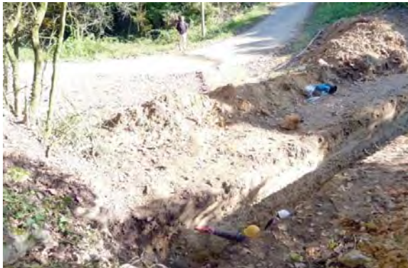
À l'arrière-plan sur la chaussée, on aperçoit une bande noire qui est, en fait, une rupture de surface associée au séisme du Teil. Elle a cassé et déplacé la route. Au premier plan, il s'agit d'une tranchée effectuée sur le côté de la route, matérialisée par un instrument rouge qu'un paléosismologue tient dans sa main. - GJF Ritz
