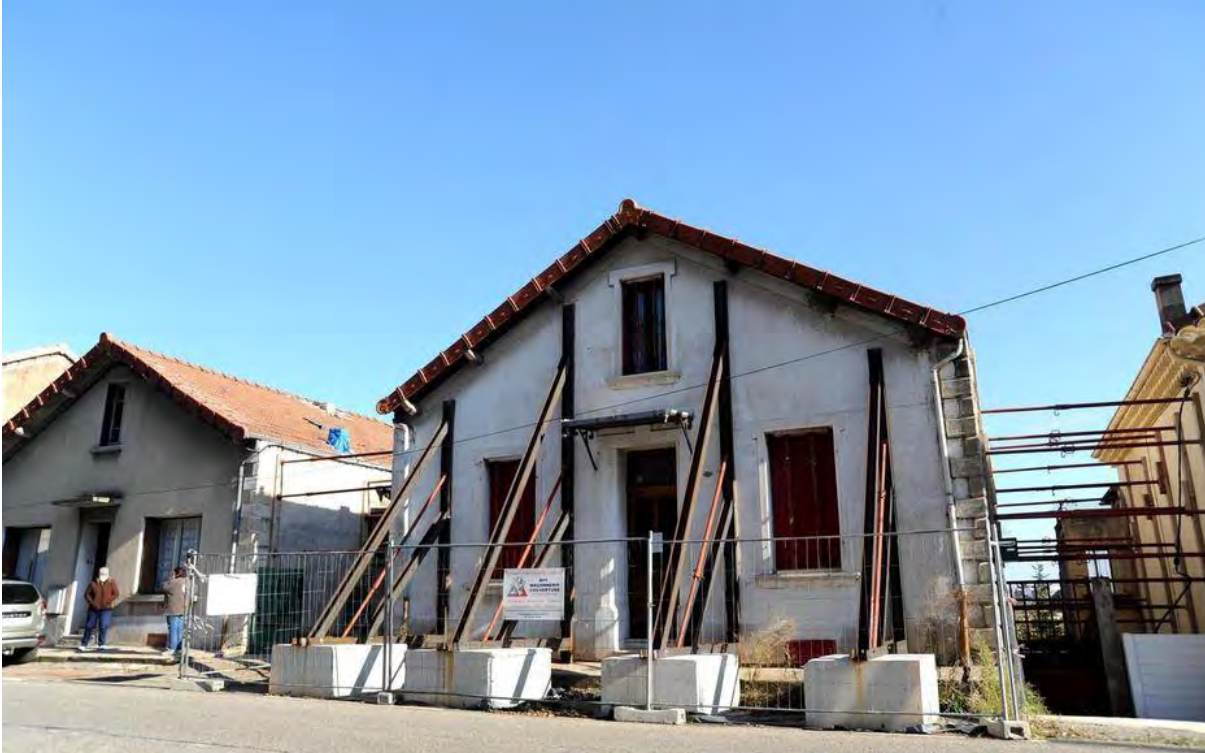
Partout au Teil (Ardèche), des étais posés pour soutenir les façades fragilisées rappellent aux habitants le tremblement de terre survenu le 11 novembre 2019. LP/Cyril Michaud
