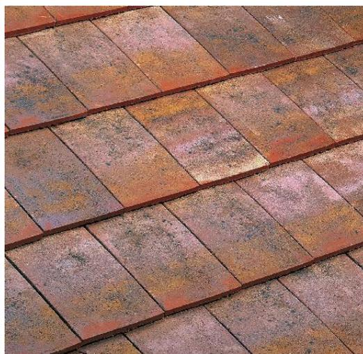
Tuiles plates à emboîtement, à petit moule, rectangulaires (22 tuiles/m<sup>2</sup>). Dimensions courantes 23,5/32cm.
