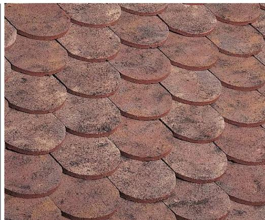
*Tuile plate traditionnelle, écaïlle. Pose traditionnelle (60/m<sup>2</sup>). Le recouvrement est important, seule la partie arrondie dépasse, les toitures sont plus épaisses, c'est la caractéristique des toitures anciennes*
