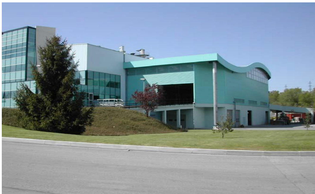
Figure 2 : Vue de l'unité de valorisation énergétique
