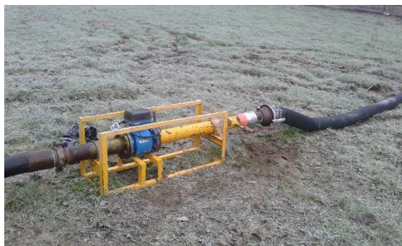
Compteur – essai de pompage en cours
