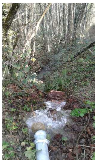
Point de rejet des eaux de pompage
