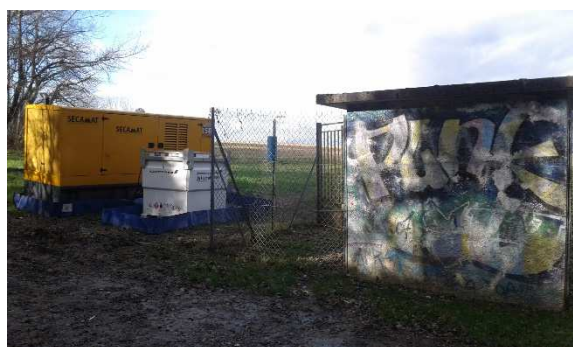
Groupe électrogène et chambre de mélange
