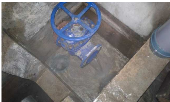
Figure 15 : Installations de la chambre de réunion du Bois d'Anthy (canalisations Ø400 et Ø200 mm)
