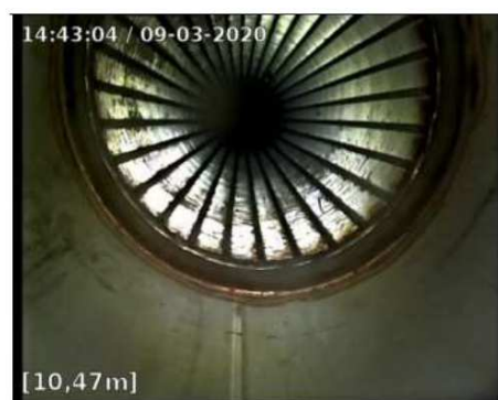
Vue du débit des crépines
