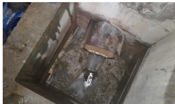
Figure 15 : Installations de la chambre de réunion du Bois d'Anthy (canalisations Ø400 et Ø200 mm)
