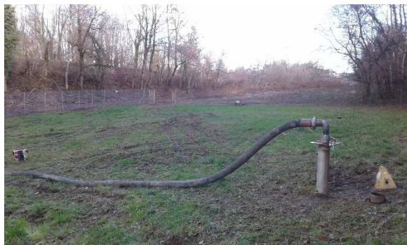
Installation – essai de pompage en cours
