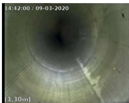
Vue du contact avec l'eau (-3,3 m/haut du tubage)
