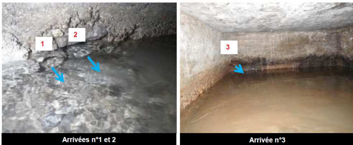
Figure 19 : Photographies de la chambre de captage et des arrivées des drains de captage (source : rapport d'inspection de CPGF-Horizon du 12/03/2020)
