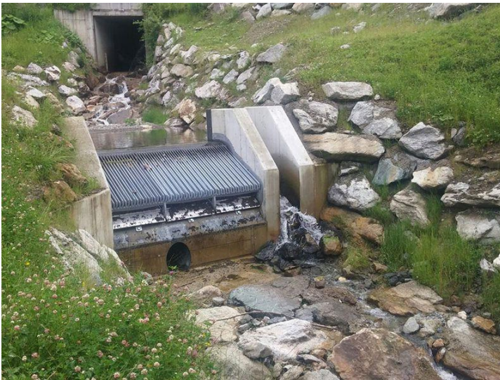
Quelques exemples de prises d'eau type par en-dessous COANDA –
