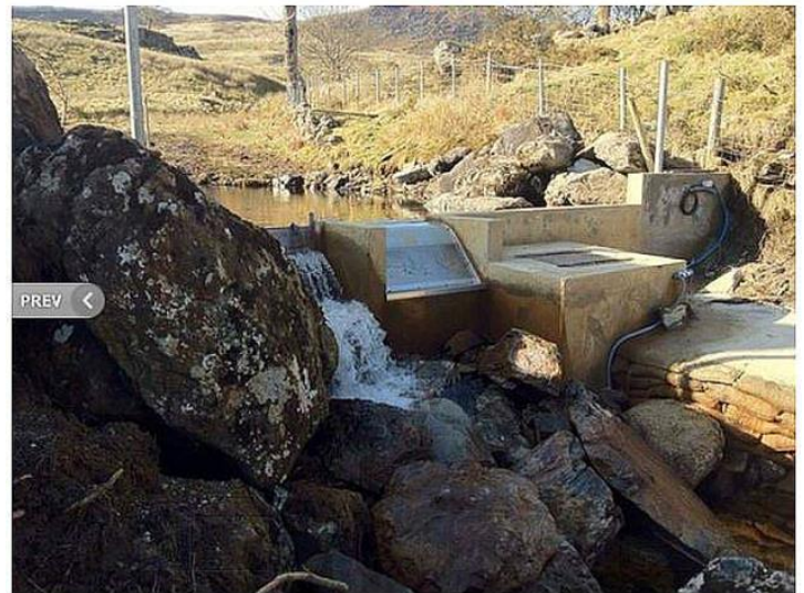
Quelques exemples de prises d'eau type par en-dessous COANDA –
