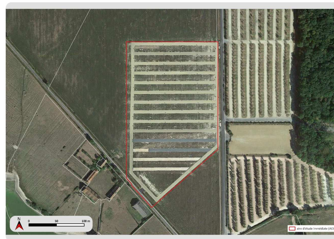
Parking en cours d'aménagement sur les terrains du projet
