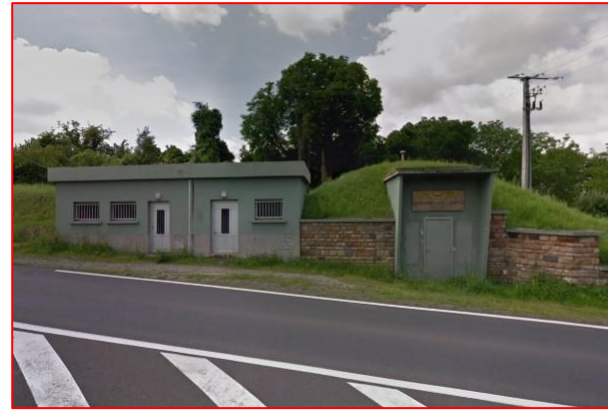
Réservoir des Sagnes le long de la RD225
