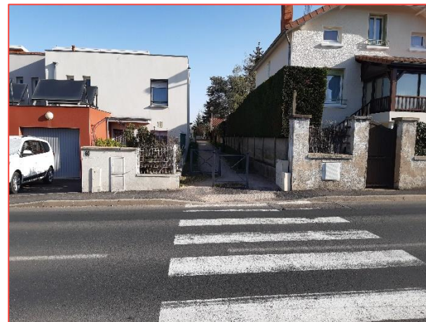
Cheminement créé entre la gare et la RD96
