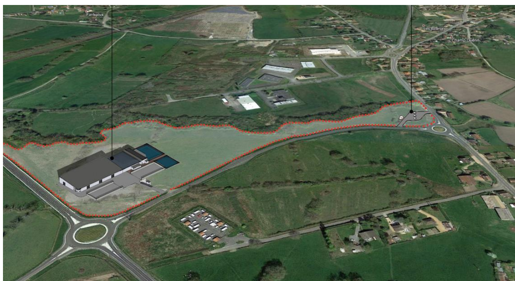
Figure 2 : Emplacement de l'unité de méthanisation SABM
