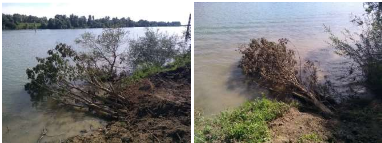
Figure 14 : photo d'ancrage en berge
