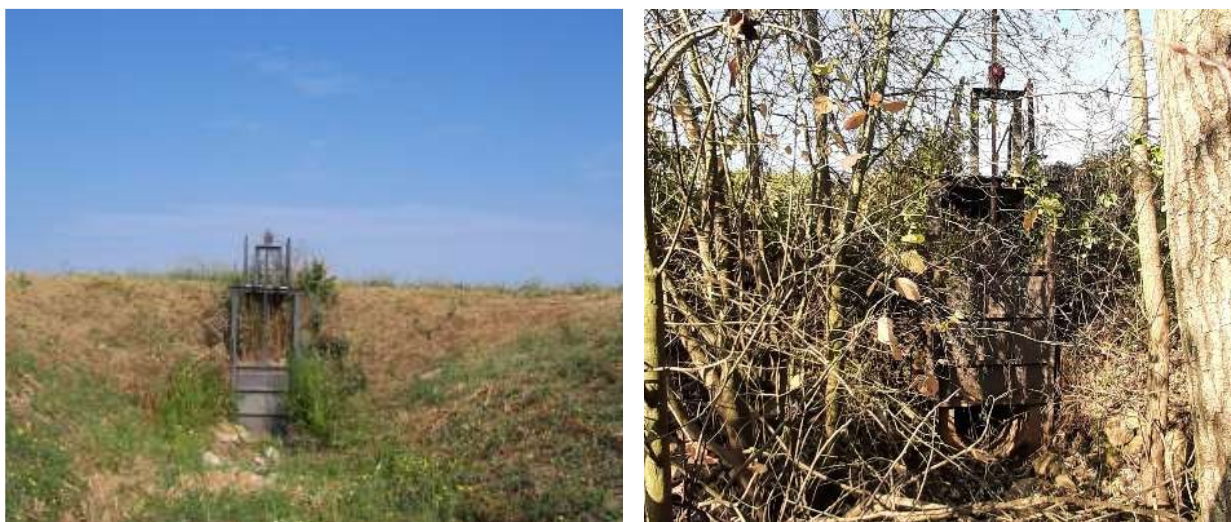
Figure 17 : photo d'une des vannes pris de les arbre et broussaille
