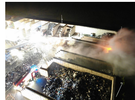
ARIA 61952 - Incendie dans un centre de tri, transit, regroupement de DEEE (source photo: SDIS 03)
