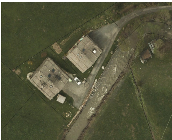
Figure 87: Maison récente construite à moins de 10 mètres du lit de l'Arly – Orthophotographie de mai 2015
