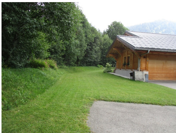
Figure 84: Maison en rive gauche du Glapet à la confluence avec l'Arly
