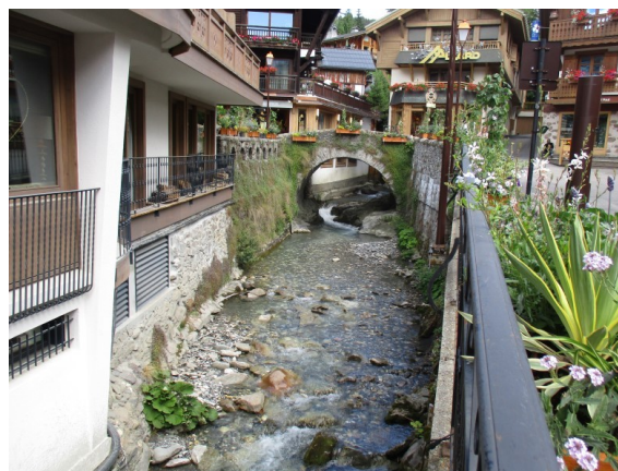
Figure 25: Pont Saint-Jean sur le torrent du Planay.
