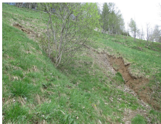
Figure 36: Niche d'arrachement sous la route du Planay.
