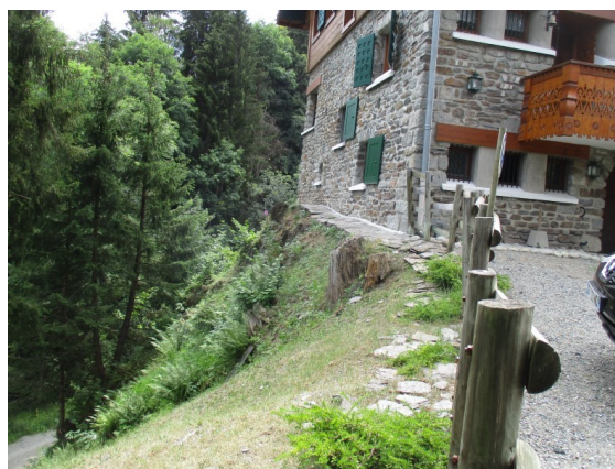
Figure 74: Bâtiment se trouvant en bordure de la falaise
