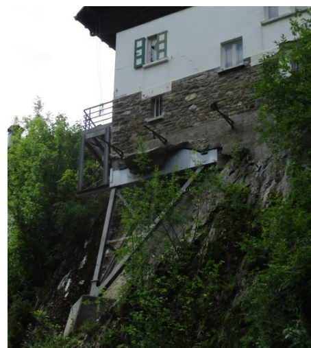
Figure 71: Ouvrage de confortement suite à l'écroulement d'une masse rocheuse
