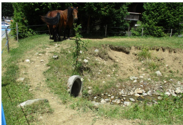
Figure 21: Entrée de la buse du ruisseau des Pettoreaux au niveau du supermarché
