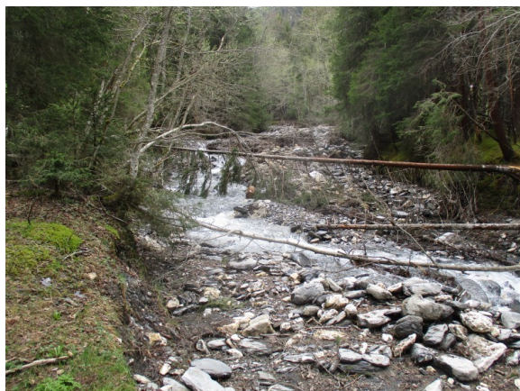
Figure 39: Matériaux déposés dans le lit du Planay
