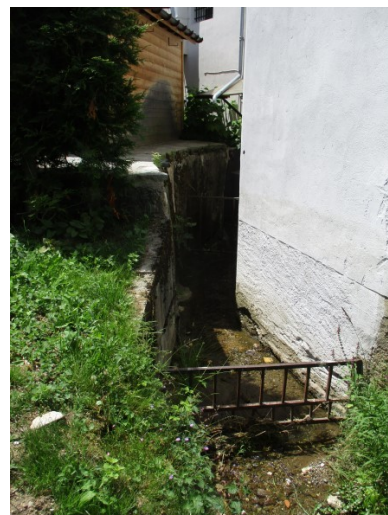
Figure 22: Grilles à l'entrée de la section couverte
