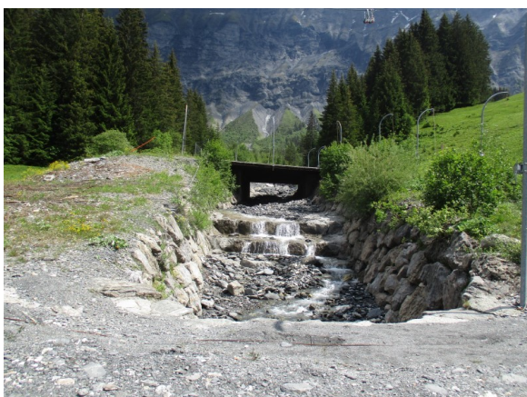
Figure 55: Platelage pour le passage de la piste de ski et enrochement de chaque côté du chenal
