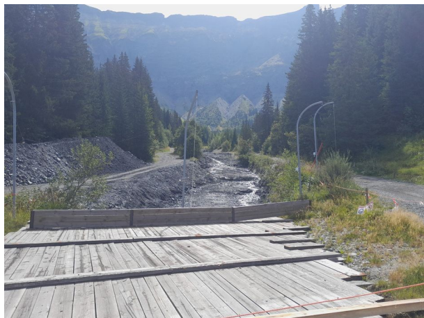
Vue du chenal en amont des aménagements après le curage post-crue.
