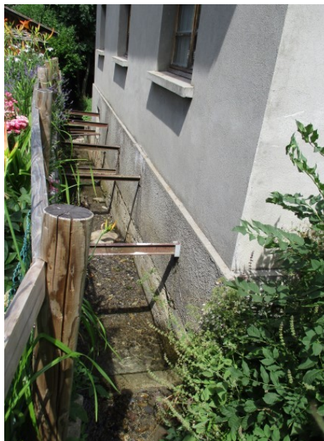
Figure 65: Lit contraint du ruisseau des Perchets à l'aval de la route des Pévôts
