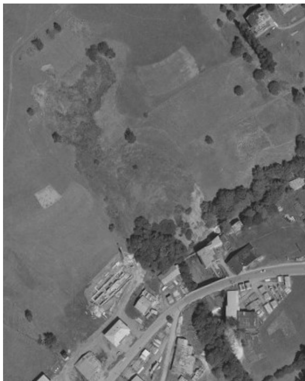
Figure 13: Glissement de terrain actif bien visible sur la photographie aérienne de 1961. Une zone active est visible en rive droite du torrent du Planay.
