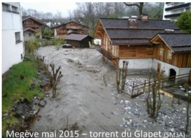
Figure 81: Vue du pont de la Poste à l'aval durant la crue de mai 2015
