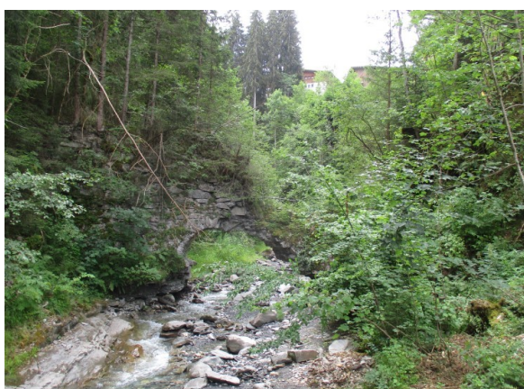
Figure 75: Ancien pont au niveau de l'impasse du Martinet
