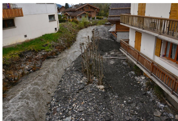
Figure 82: Vue du pont de la Poste en fin de crue en mai 2015
