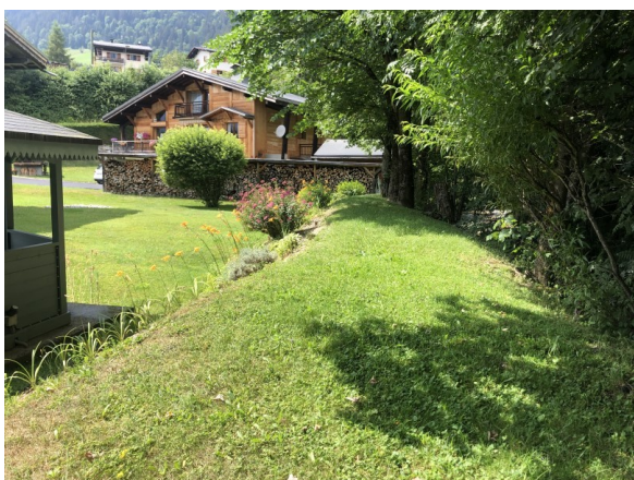
Figure 86: Digue en rive droite de l'Arly au lieu-dit Bandu.
