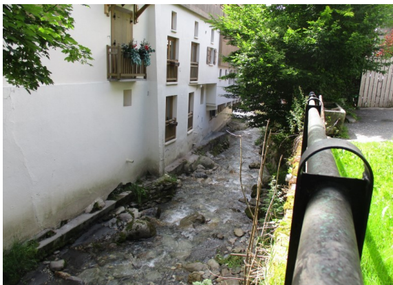
Figure 24: Immeuble le long du torrent avant la rue Saint-Jean.
