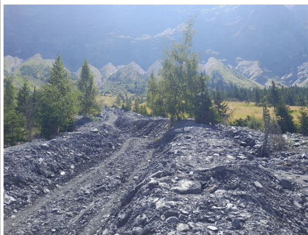
Le chenal après les travaux pots-cruie dans la zone de débordement. Noter les dépôts en rive gauche, qui marquent vraisemblablement le point de débordement.
