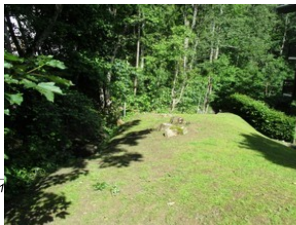
Figure 89: Digue protégeant le rez-de-chaussée d'un immeuble
