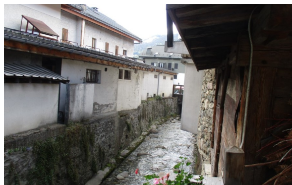
Figure 31: Lit chenalisé du torrent du Planay avant le passage sous la propriété de l'hôtel du Vieux-Moulin
