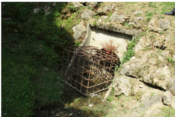
Figure 60: Grille à l'entrée de la section busée
