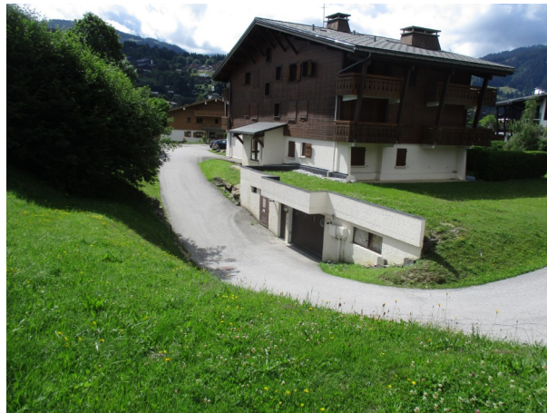
Figure 14: Immeuble en contre-bas du ruisseau ayant eu ses sous-sol inondés.
