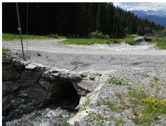
Figure 54: Passage busé pour la piste de ski et gué en cas d'obstruction
