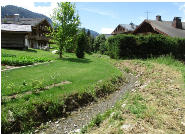
Figure 23: ruisseau du Crêt avant sa section busée sous la RD 1212.
