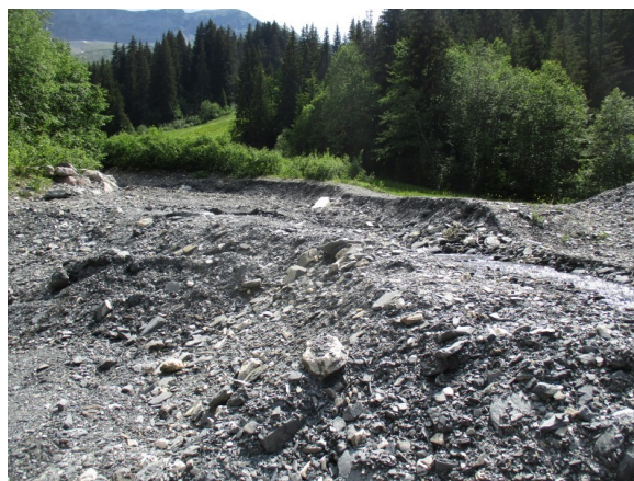
Figure 58: Accumulation de matériaux suite à la dernière crue au niveau de l'altiport (visite en juin 2020)
