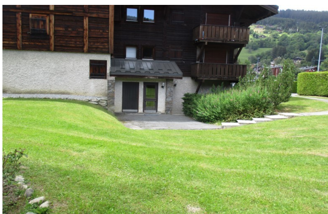
Figure 16: Immeuble inondé – côté nord-est, porte par où l'eau est entrée
