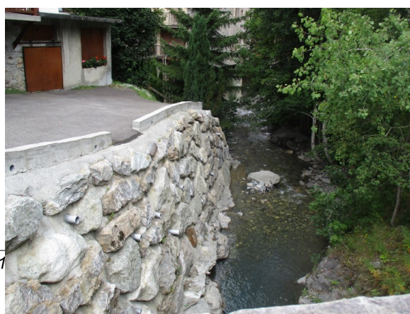
Figure 76: Remblais et enrochement à l'aval du pont de l'impasse de la Forge
