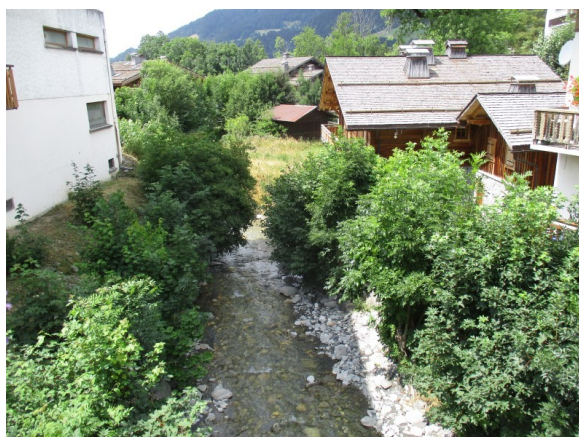
Figure 83: État des berges en juillet 2020
