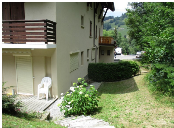
Figure 68: Sous-sol et rez-de-jardin inondable en cas de débordement du ruisseau des Perchets
