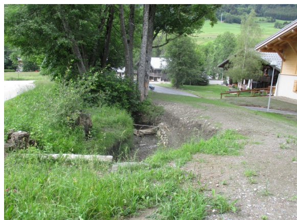
Figure 91: Levée de terre protégeant la rive droite des éventuels débordements.
