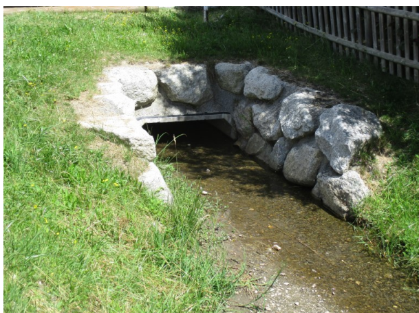
Figure 18: Dalot en partie obstrué
