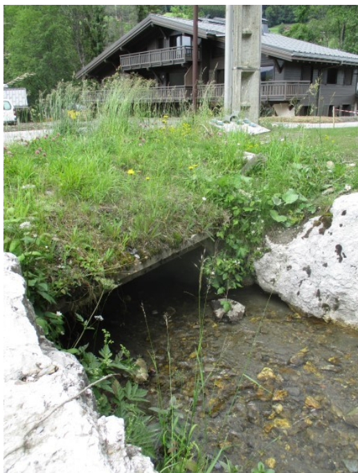
Figure 90: Dalot au niveau de la route d'accès à la Zone d'activité.
