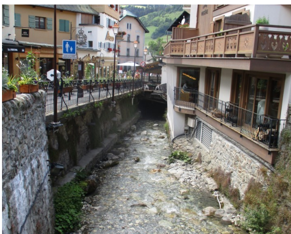
Figure 26: Entrée de la section couverte sous la place de l'Église
