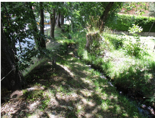
Figure 17: Lit perché du ruisseau du Riglard le long du parking de la télécabine
