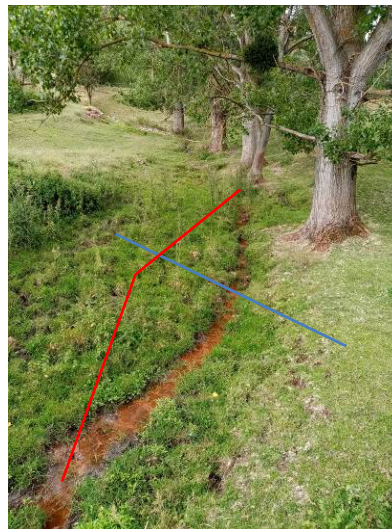
By pass du cours d'eau pendant les travaux
