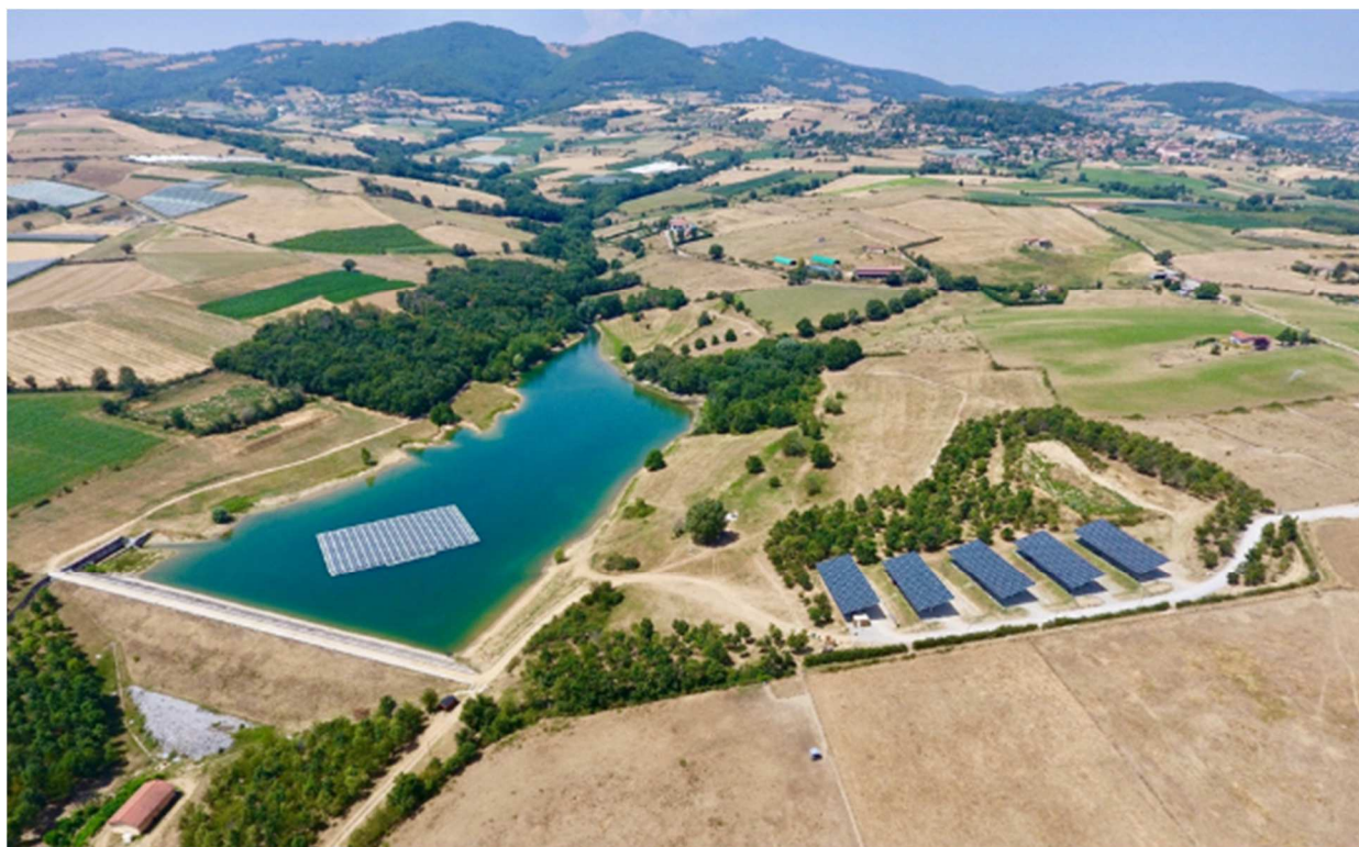
Centrales photovoltaïques du lac de la Madone flottante et en ombrières – MORNANT(69) – juillet 2019
