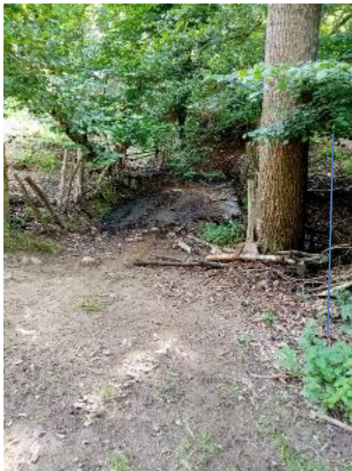
Canalisation DN 100mm
