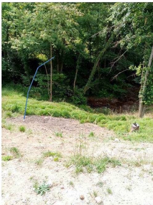
Canalisation DN 150mm
