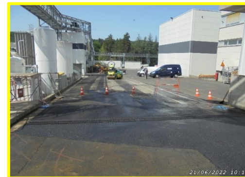
Finalisation avaloir rue 9 (risque rejet accidentel)
