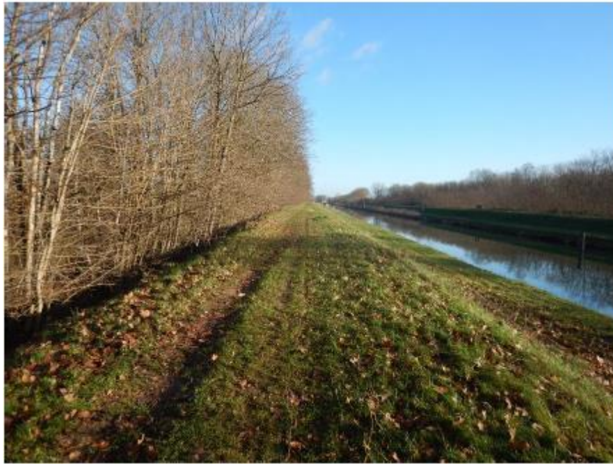
Figure 3 : Vue générale de la digue au droit du projet
