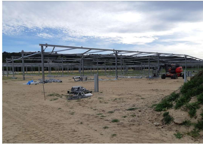
Figure 17. Installation de panneaux photovoltaïques à Saint-Restitut dans la Drôme, sur une pelouse sableuse au voisinage direct de l'unique station rhônalpine de Silene portensis (photo : © V.Bonnet - CBNA).
