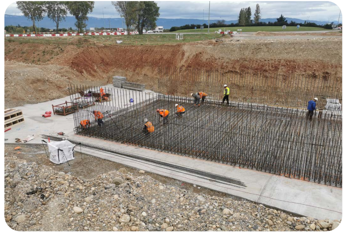
Un ferrailage est posé pour armer le radier (plateforme) du futur pont et le rendre plus résistant.
