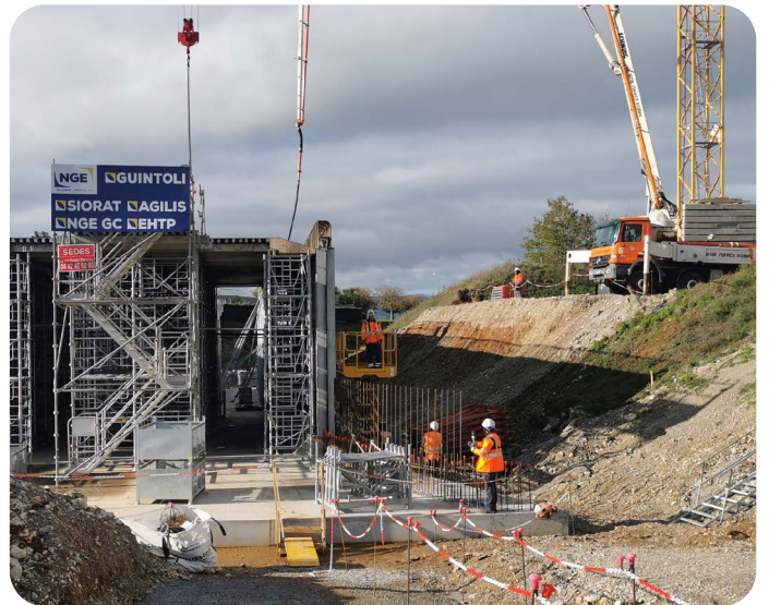
Les piliers sont coffrés, puis bétonnés. La traverse (dalle de couverture) est ensuite étayée (éléments de soutien).
