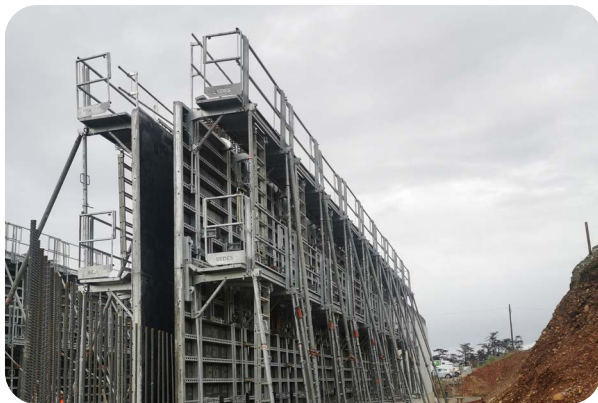
Les piliers sont coffrés, puis bétonnés. La traverse (dalle de couverture) est ensuite étayée (éléments de soutien).
