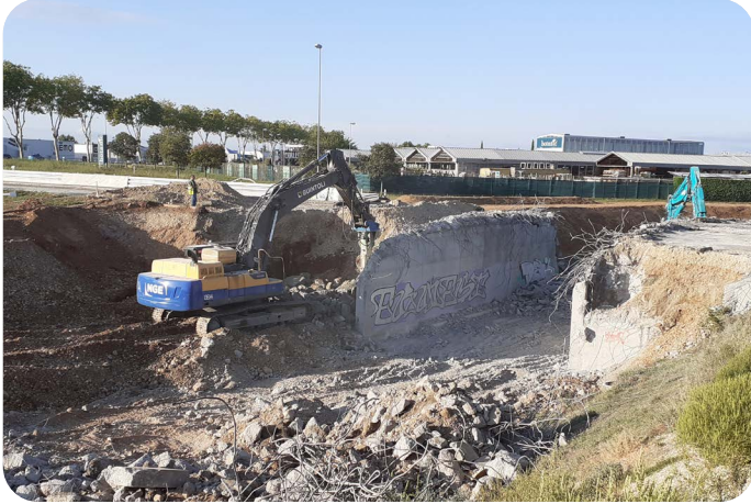
La structure de l'ancien pont est démolie au brise roche hydraulique.
