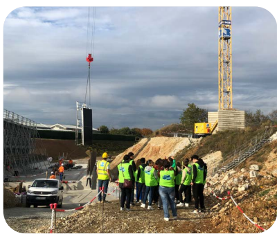
Aperçu d'une opération de grutage
