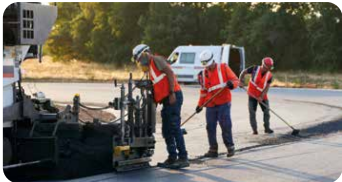
L'enrobé des chaussées est appliqué au finisseur, l'un des derniers engins à intervenir sur le chantier de construction d'une route.
