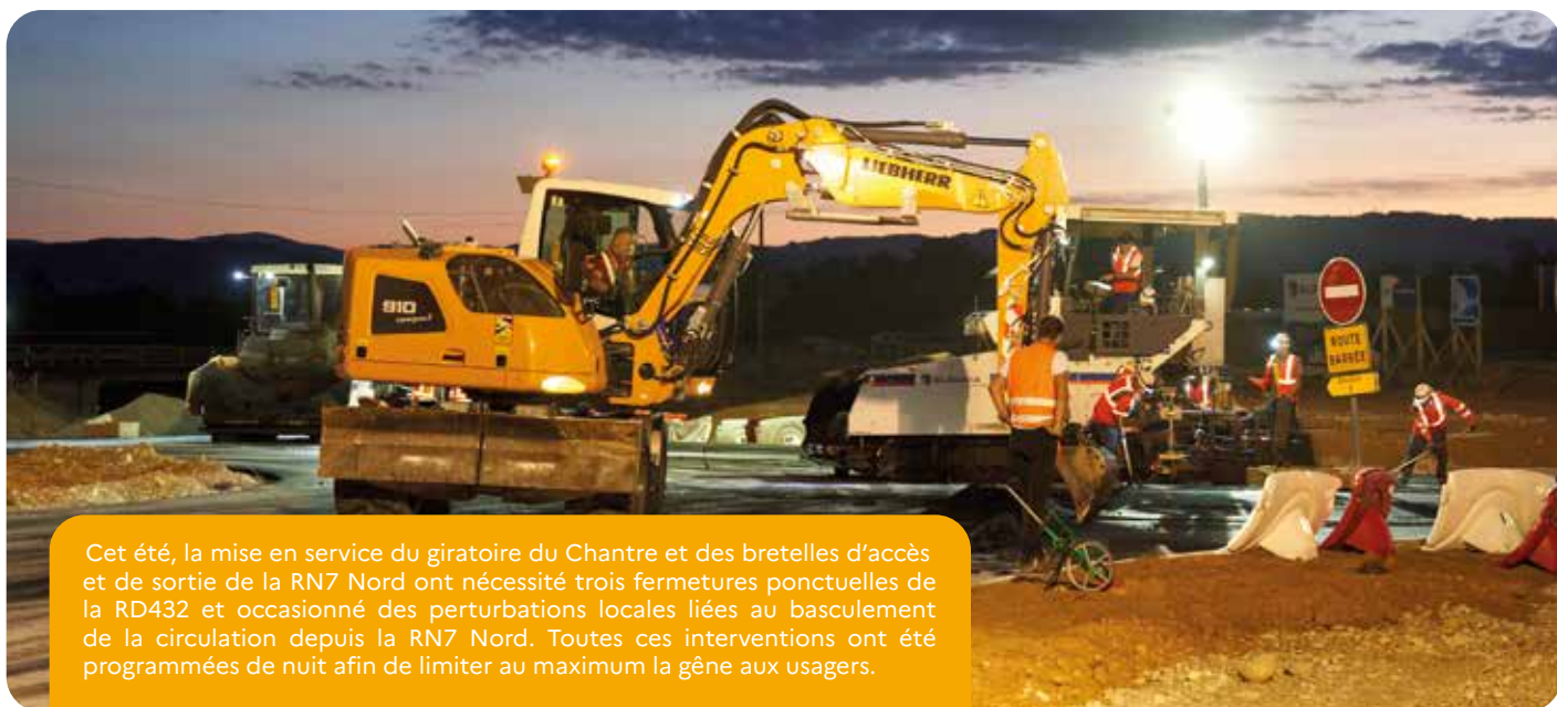
L'application de lait de chaux sur la couche d'accrochage évite l'arrachement de celle-ci sous les pneumatiques des engins et la présence de résidus de bitume aux abords du chantier.
