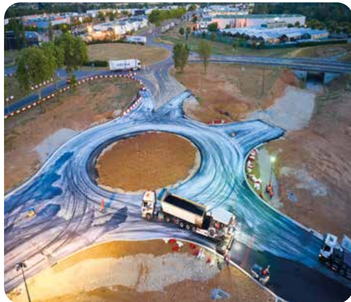
L'application de lait de chaux sur la couche d'accrochage évite l'arrachement de celle-ci sous les pneumatiques des engins et la présence de résidus de bitume aux abords du chantier.
