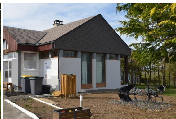
Bâtiment accueil façades Sud et Est
