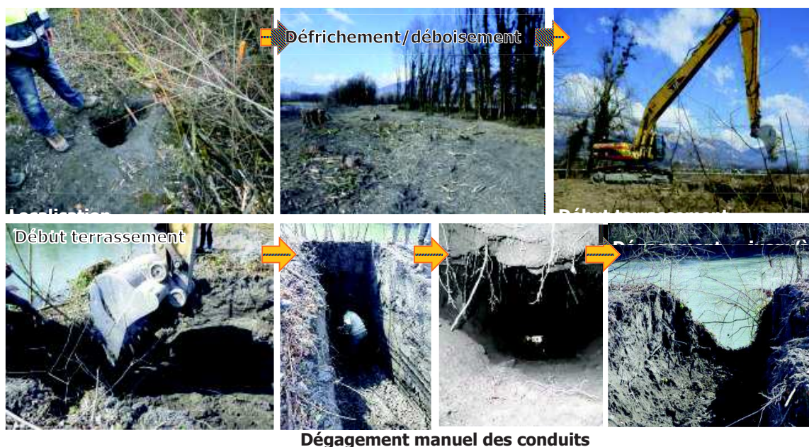
Figure 78 : Protocole de démantèlement de terrier-hutte développé par l'ONCFS sur les travaux de l'Isère Amont et appliqué dans le cadre du démantèlement éventuel lié aux travaux.
