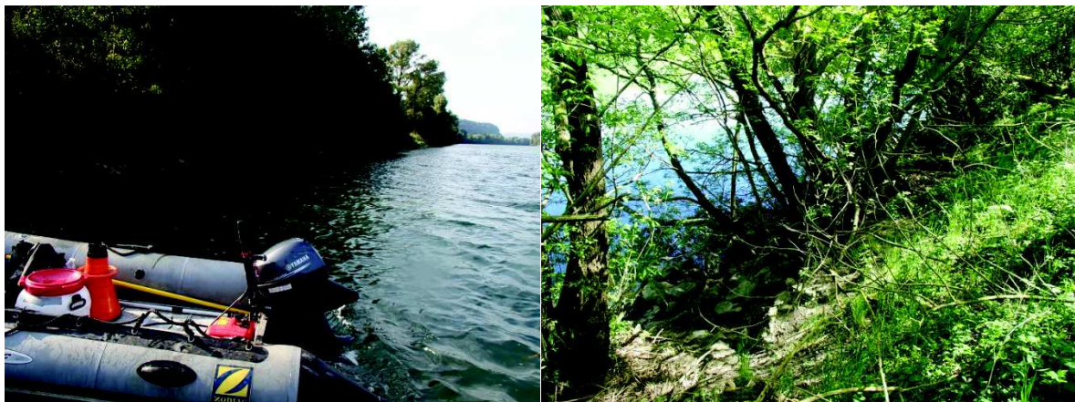
Figure 36 : Formation alluviale colonisant la digue en enrochement ©SAGE Environnement
