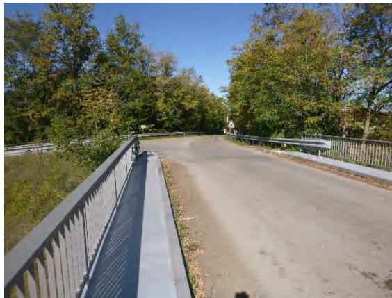
Photo 12 Pont traversant l'A410, route des Grange.
