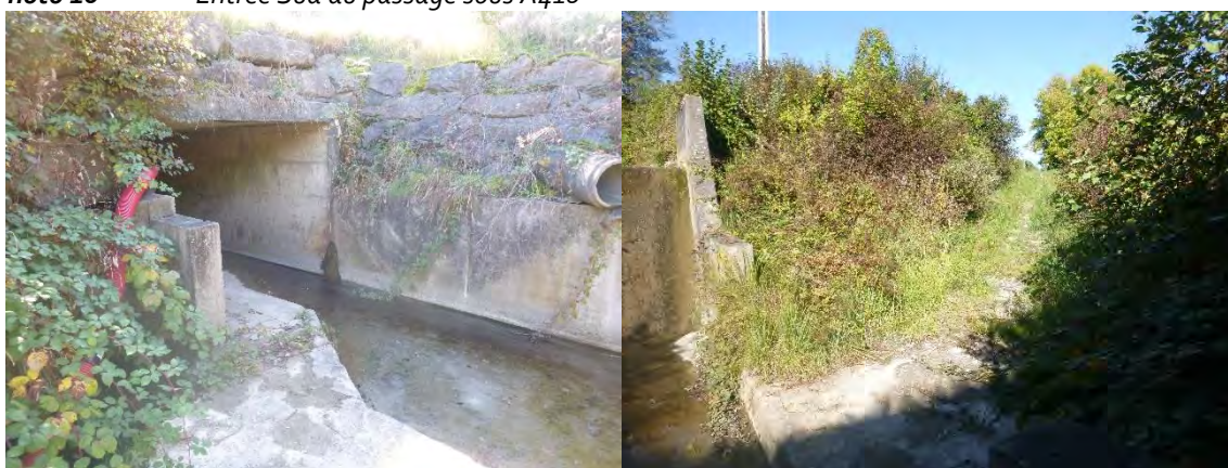
Photo 17 Entrée Nord du passage sous A410
