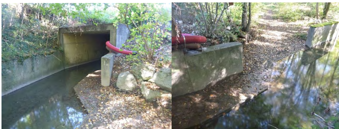
Photo 16 Entrée Sud du passage sous A410
