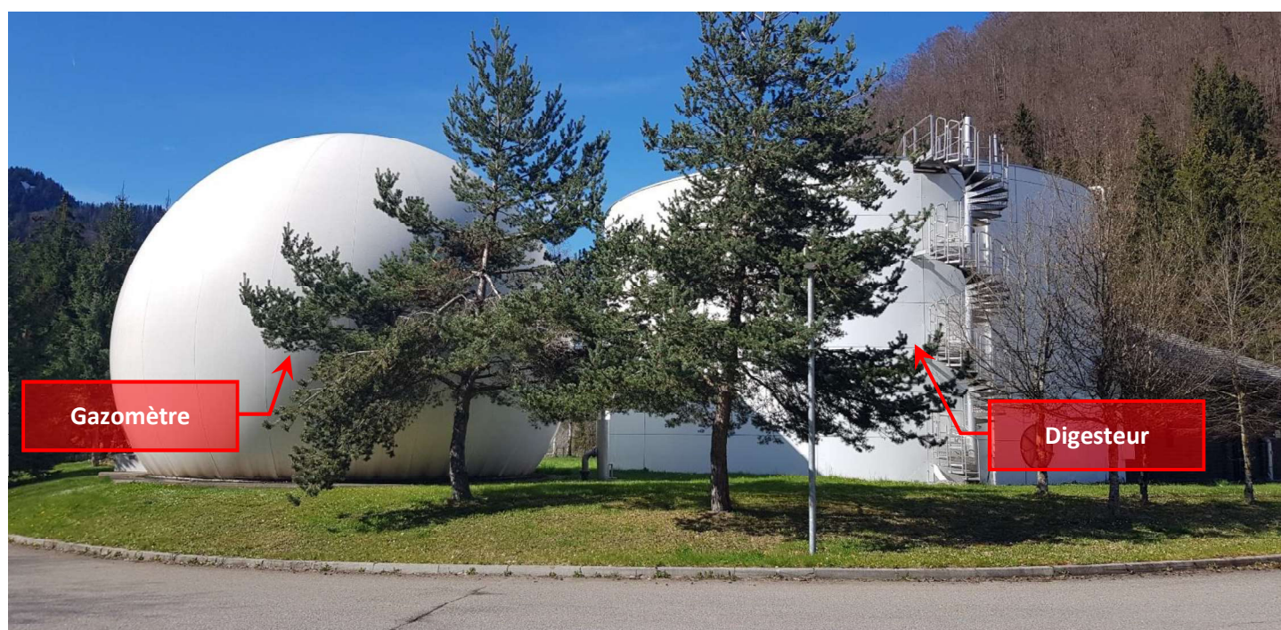
3. Installations de méthanisation vues depuis la voie de desserte interne de la station d'épuration (prise de vue avril 2024)
