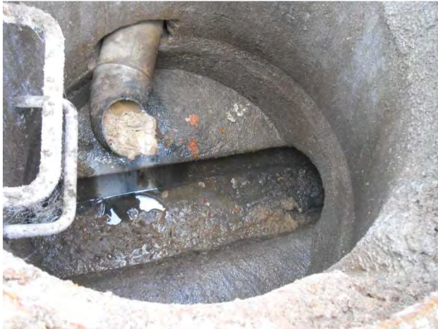
Eaux usées dans le réseau pluvial provenant de branchements particuliers (P28 et P138)
