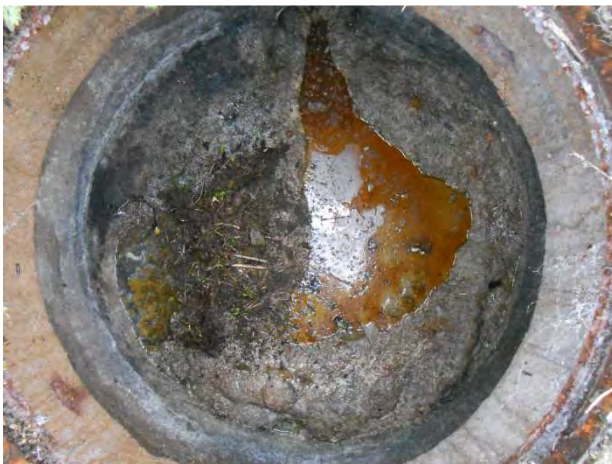
Réseau en charge et dépôts aux regards 248 et 325
