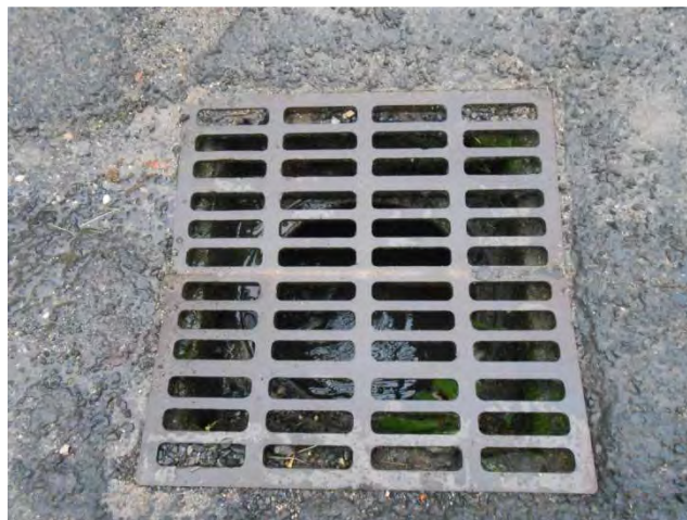
Rue des Lilas, grille avec passage direct des eaux usées
