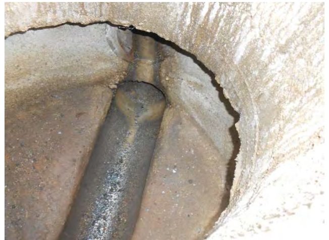
Eaux usées dans le réseau pluvial provenant de branchements particuliers (P28 et P138)
