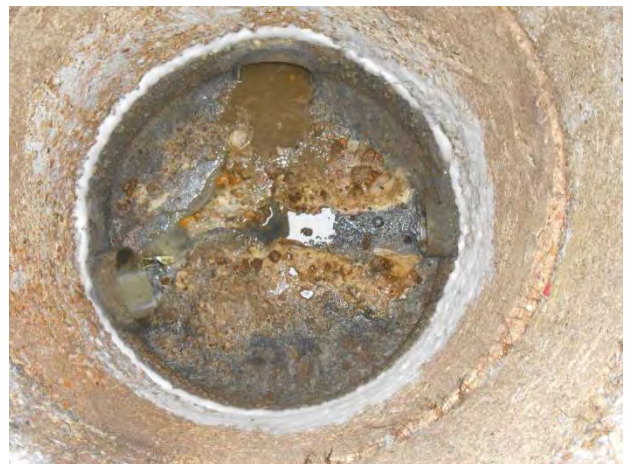
Réseau en charge et dépôts aux regards 248 et 325
