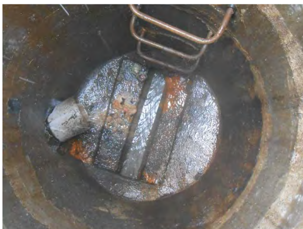
Infiltrations aux regards 189 et 354
