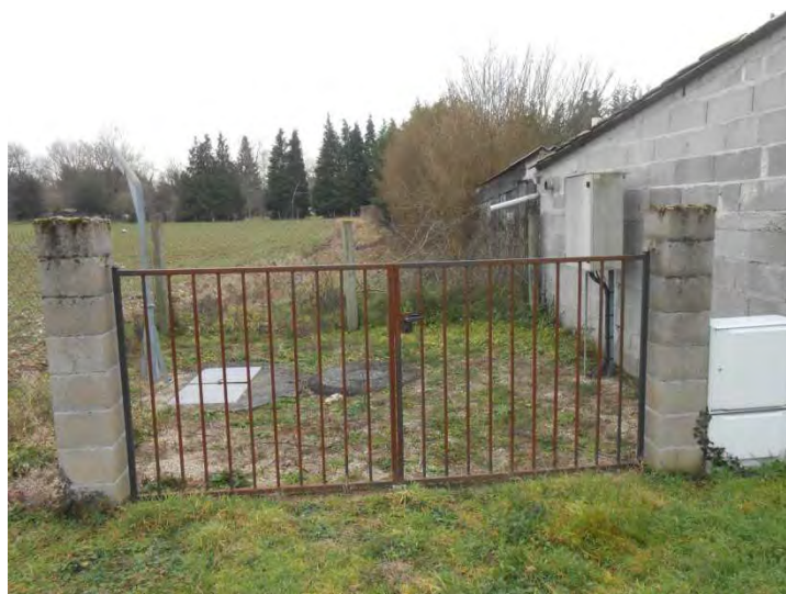
Poste de relevage Chez Planche
