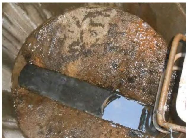
Infiltrations aux regards 189 et 354
