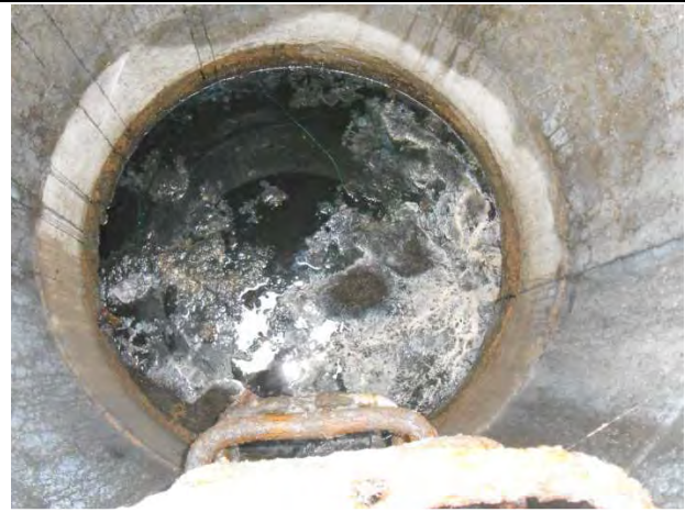
Réseau bouché et en charge aux regards 6 et 168
