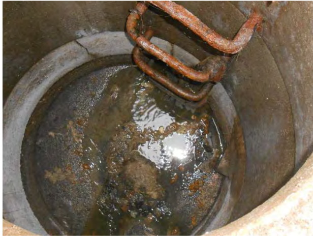
Fissures et perforations aux regards 89 et 99
