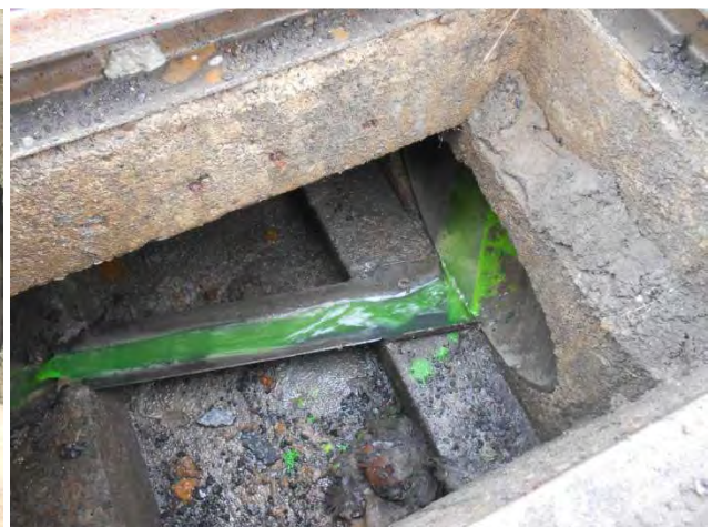
Déversoir d'orage bouché et déversoir d'orage nettoyé
