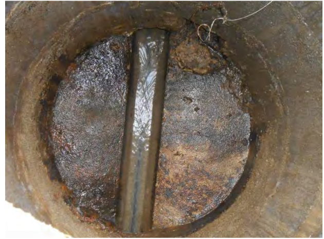
Fissures et perforations aux regards 89 et 99
