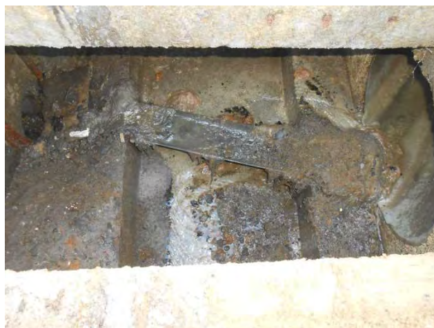
Déversoir d'orage bouché et déversoir d'orage nettoyé
