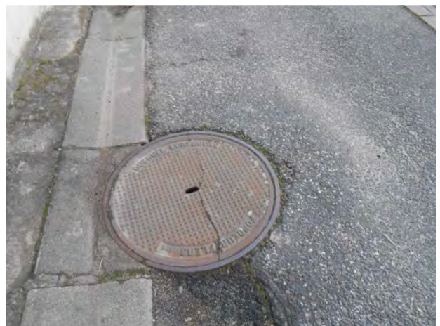
Tampons des regards 21 (descellé) et 145 (cassé)
