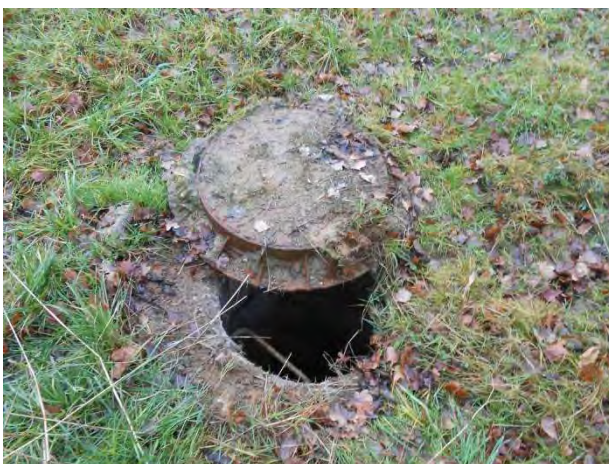
Tampons des regards 21 (descellé) et 145 (cassé)
