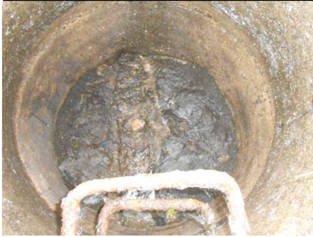
Réseau bouché et en charge aux regards 6 et 168
