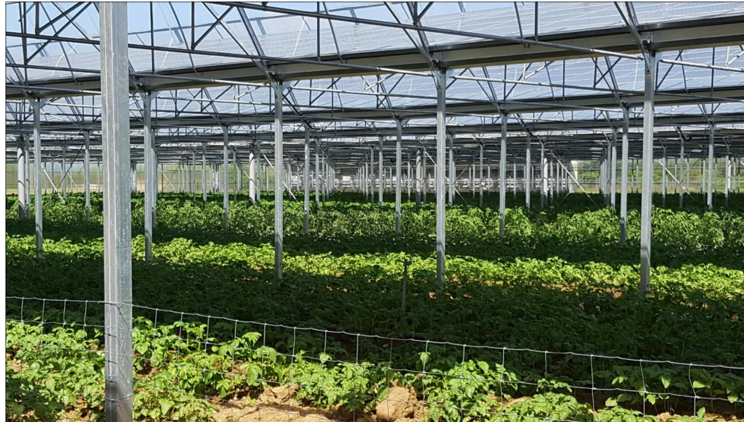
Serres agricoles de M. FREYSSIN, situées sur la commune de Vaunaveys-la-Rochette dans la Drôme
