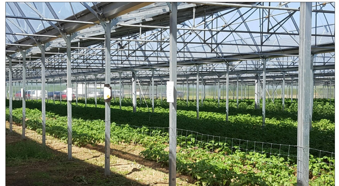
Serres agricoles de M. FREYSSIN, situées sur la commune de Vaunaveys-la-Rochette dans la Drôme
