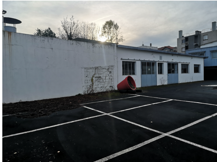
Vue depuis le parking de la parcelle 270
