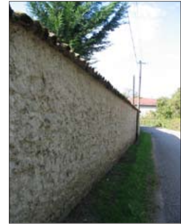
Mur en pisé ensuit à la chaux
