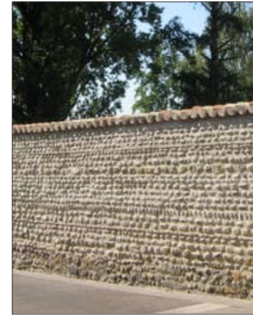
Mur en galets
