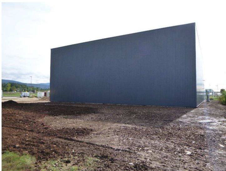
Figure 12 : Parcelle en travaux.
