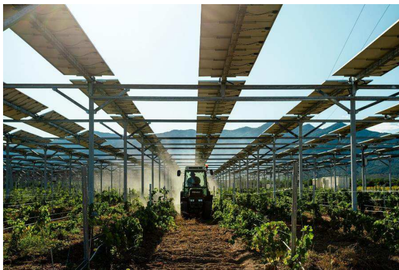
Photo 2 : structure permettant le passage d'engins agricoles
