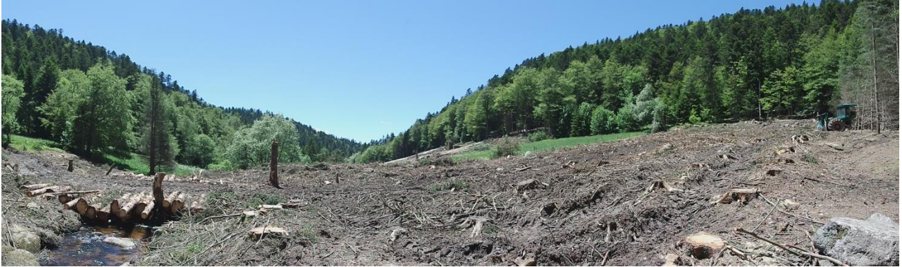
Vue partielle du fonds de la vallée après les travaux de coupe rase. (photo CEN Auvergne)
