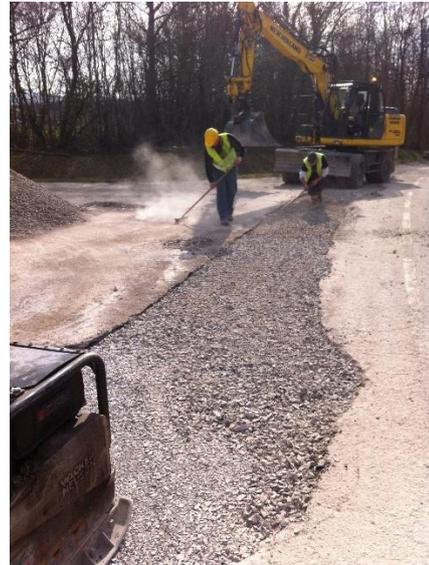
Figure 38. Couche de réglage en 0/31,5 (source BG Ingénieurs Conseils SAS)
