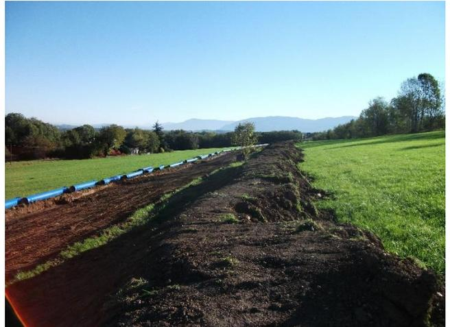
Figure 33. Mise en cordon de la terre végétale (source BG Ingénieurs Conseils SAS)
