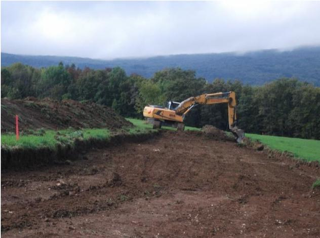
Figure 32. Décapage de la terre végétale (source BG Ingénieurs Conseils SAS)
