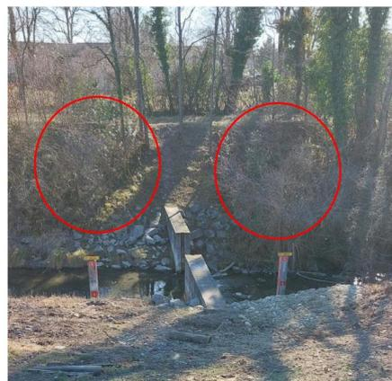
Figure 5 : Défrichage et embâcles au droit de l'ouvrage en rive gauche amont
