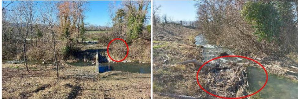
Figure 2 : Défrichage et embâcle de l'ouvrage en rive droite aval
