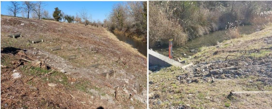
Figure 7 : Rondins de bois ouvrage en rive gauche aval
