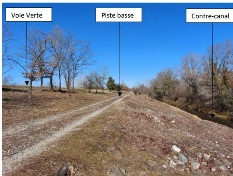
*Figure 30 : Piste basse du barrage latéral rive gauche*
