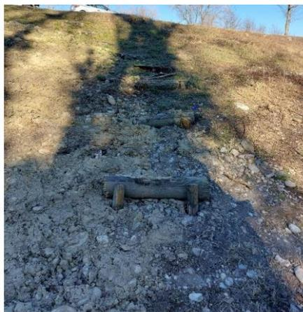
Figure 8 : Rondins de bois ouvrage en rive gauche amont
