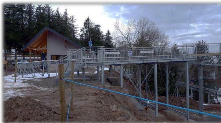
Photo 20 : Exemple de gare motrice enterrée à l'amont
