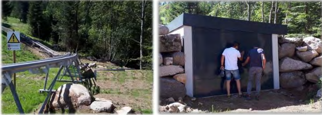
Photo 21 : Exemples de gare enterrée
