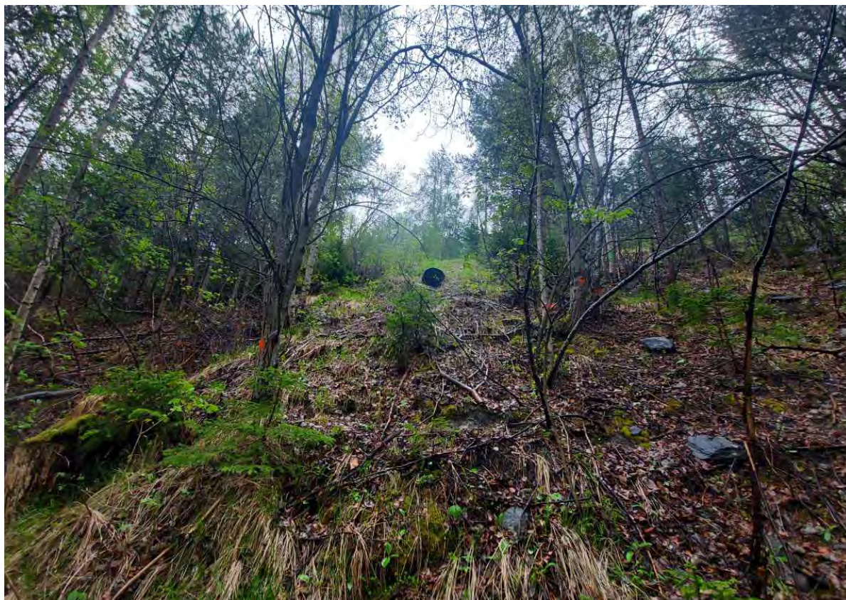
Figure n°8 – vue de la buse et de la morphologie de l'emprise de la grille centrale
