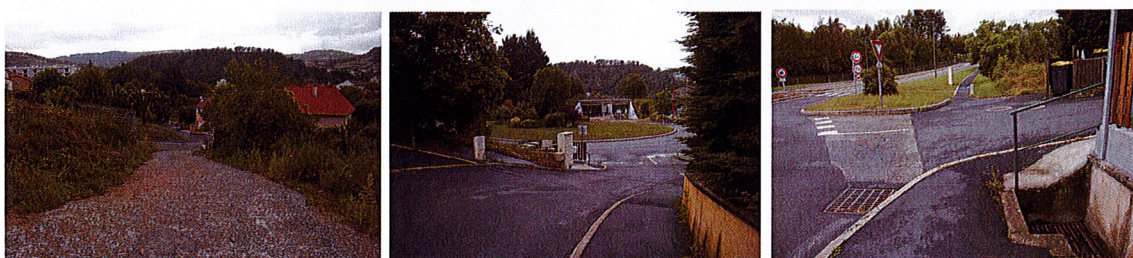
Voirie interne du lotissement, sa jonction avec le rond-point, et la RD 103
