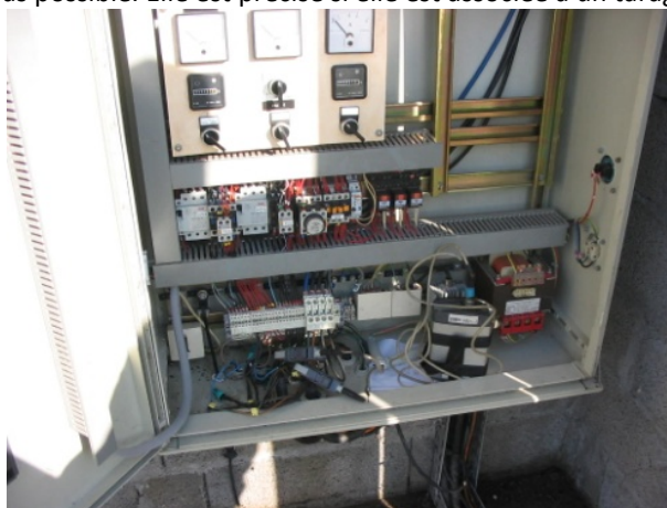
Fig. 2. Pincettes ampérométriques pour le suivi du fonctionnement de pompes
