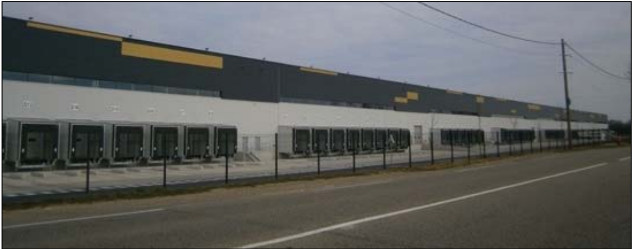
Constructions aménagées sur la plateforme logistique du Buchet
