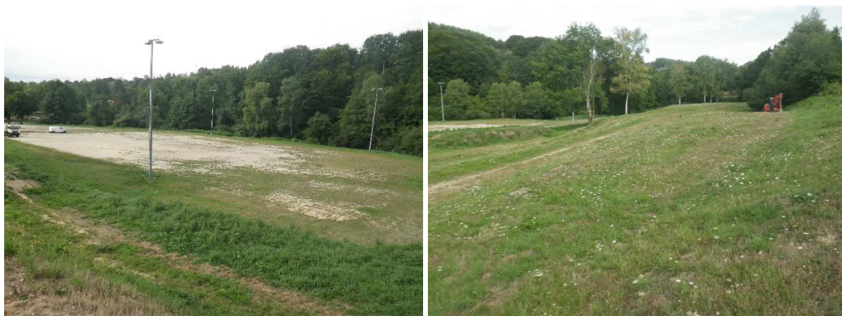
Photographies du site datées du 10/09/2019 (Partie basse à gauche, partie talutée à droite)
