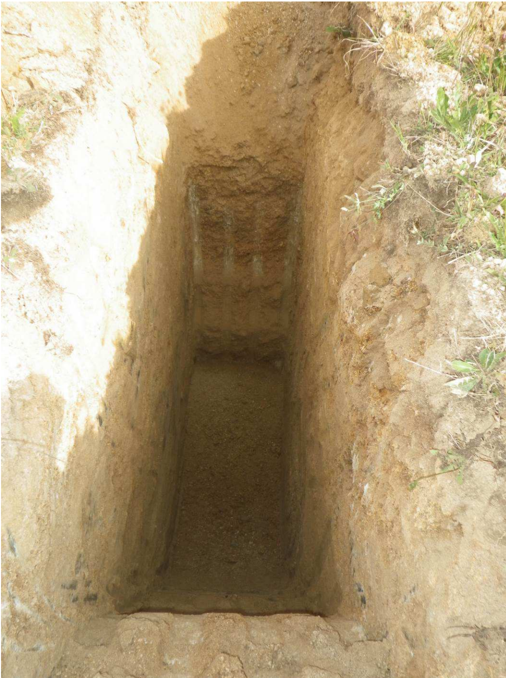
Fond de fouille
