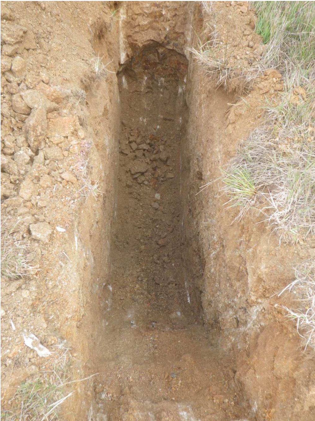
Fond de fouille
