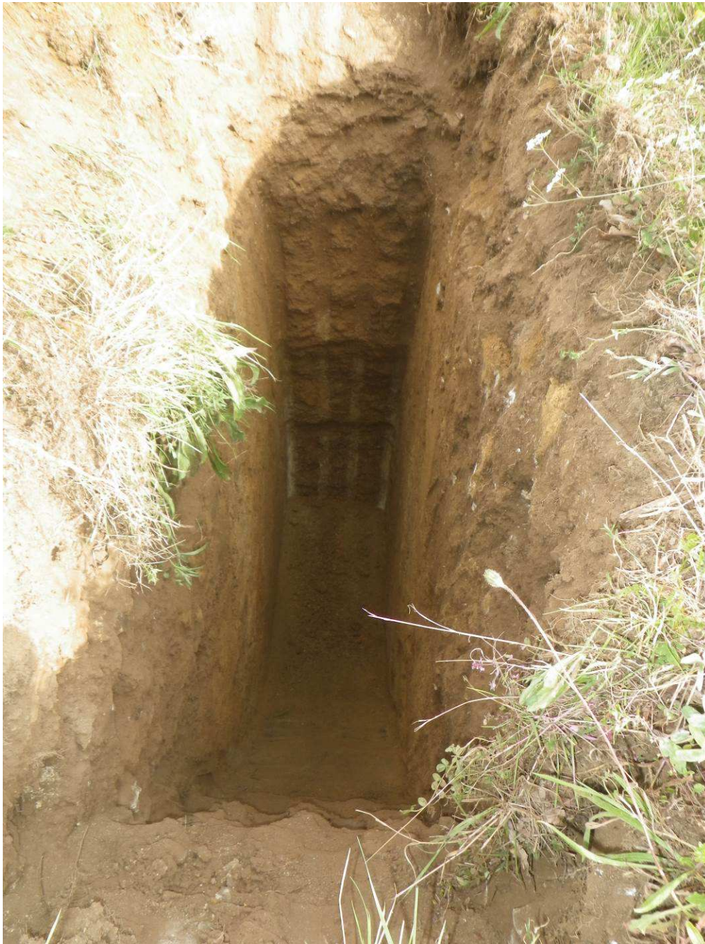
Fond de fouille
