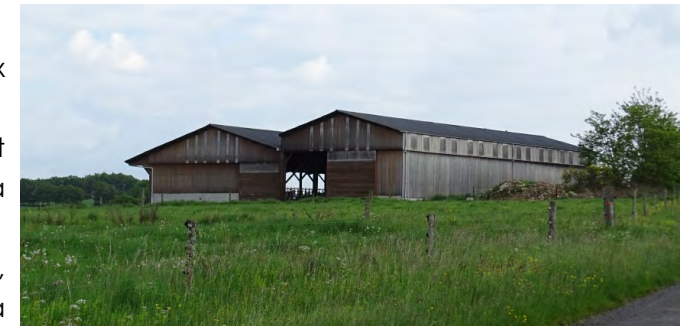
Vue des bâtiments agricoles existants depuis la route entre Espinet et Comblat
