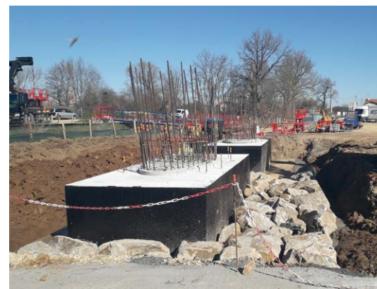
Semelle de la pile P2. Aciers en attente pour liaison avec la future pile
