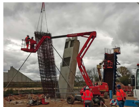
Culée C0 : le mur de front et les murs en aile (éléments préfabriqués). A l'arrière des murs, le ferrailage et les blocs de remblai allégé.
