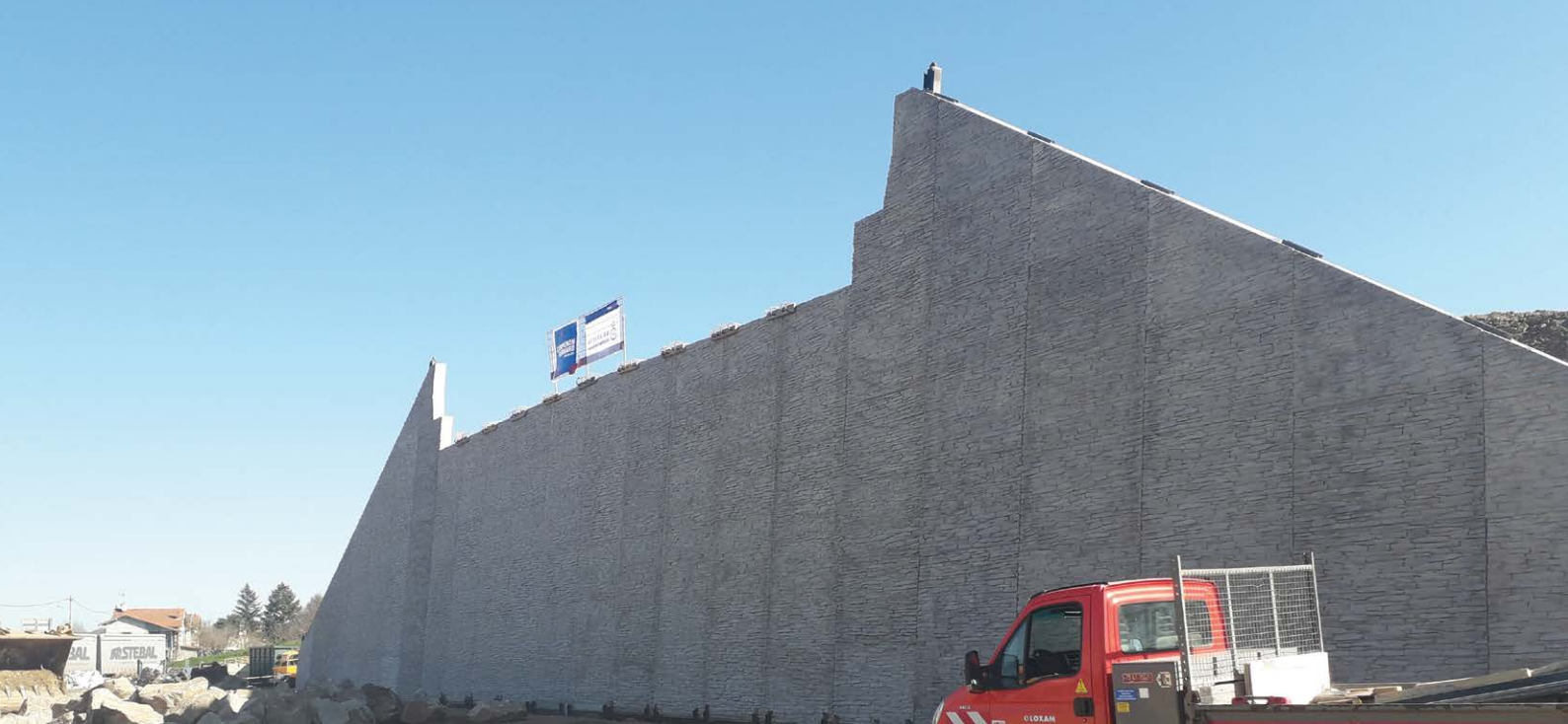
Murs de la culée C3, côté Est du viaduc. Le parement est constitué d'un motif de pierre sèche
