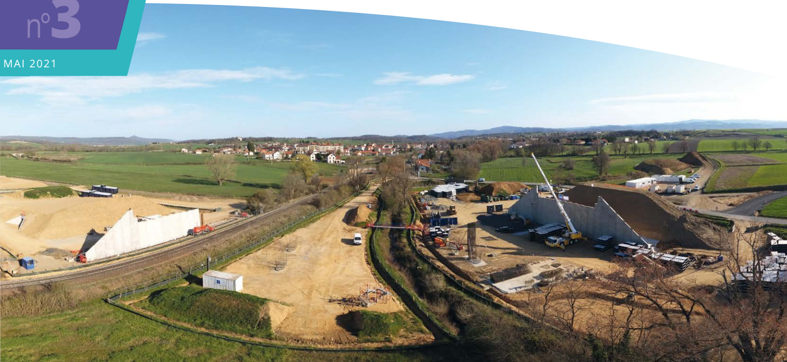
La zone de chantier du viaduc de la Leuge, au sud d'Arvant
