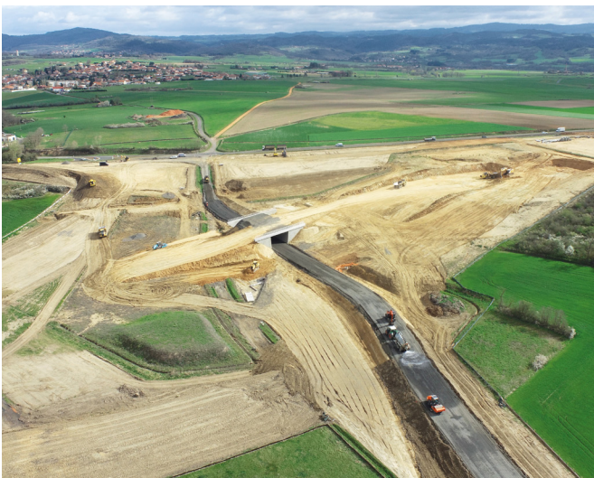
Les travaux de terrassement ont débuté
