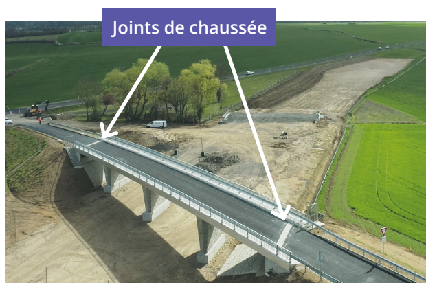
Ouvrage ordinaire avec joints de chaussée
