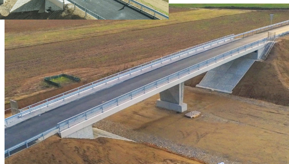
PS9 : ouvrage semi-intégral, sans joints de chaussée
