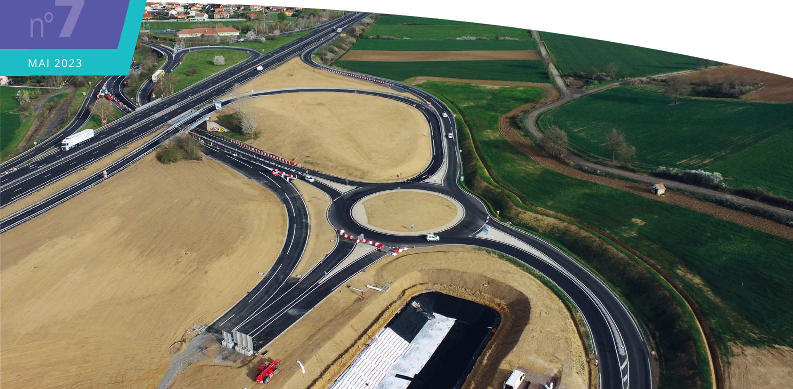
L'échangeur de Lempdes-sur-Allagnon est terminé
