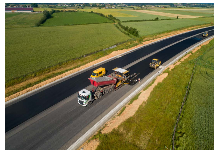
Pose des enrobés sur la future 2x2 voies
