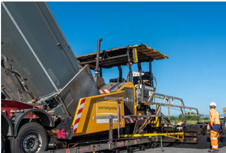
Camion benne chargeant le finisseur
