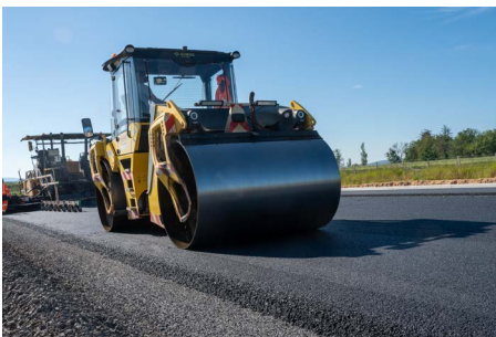
Compacteur juste après la pose de l'enrobé
