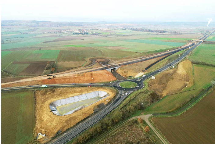
L'échangeur de Cohade et le bassin d'assainissement n° 5
