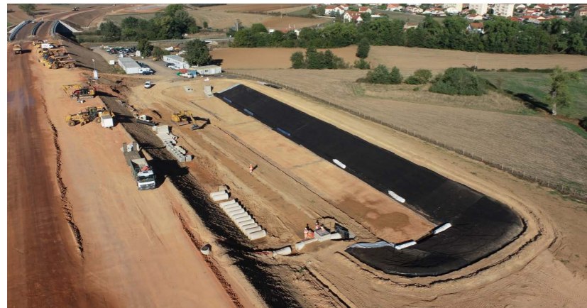
Bassin d'assainissement n° 3 : pose de la géomembrane qui assure l'étanchéité
