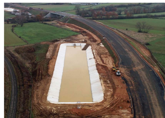
Bassin d'assainissement n° 2 140 x 17 mètres 10 500 m³ de déblais
