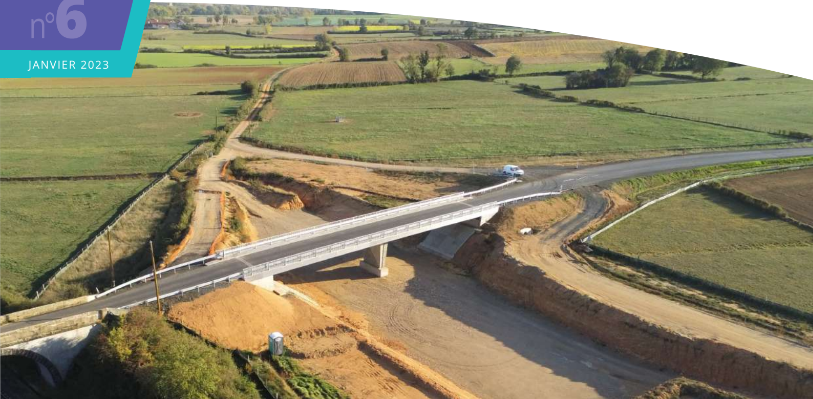
La route départementale 192 est rétablie !
