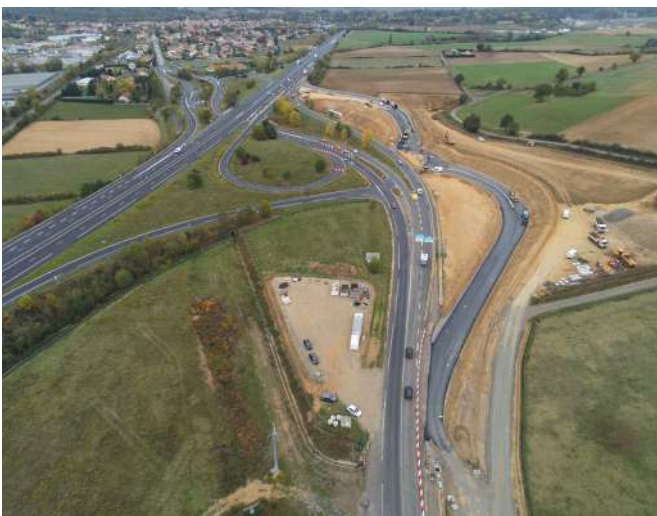
Les travaux sur l'échangeur de Lempdes se poursuivent
