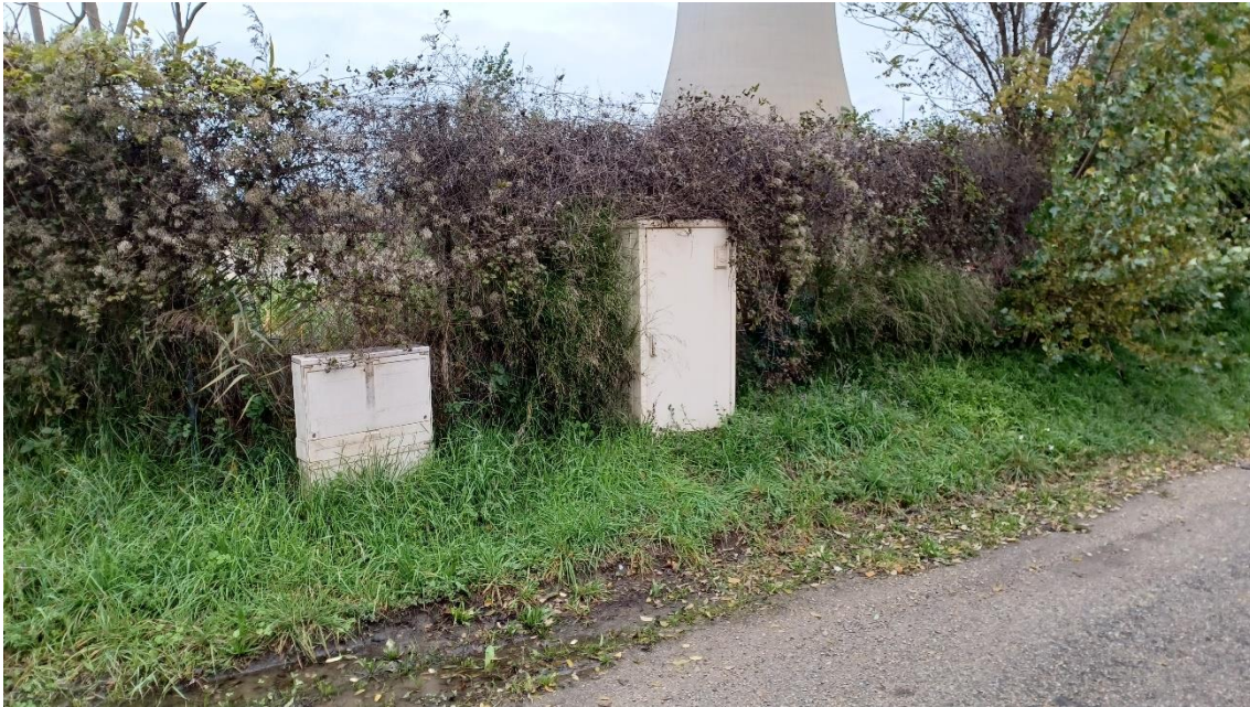
Figure 14 : Départ de l'alimentation du réseau éclairage
