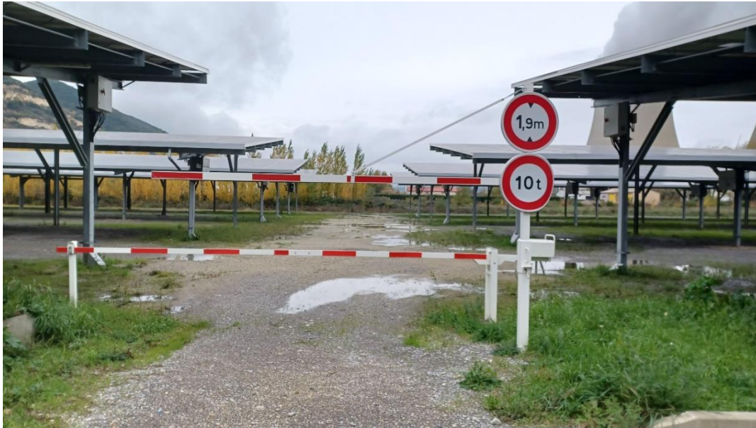
Figure 16 : Exemple ensemble portique/barrière
