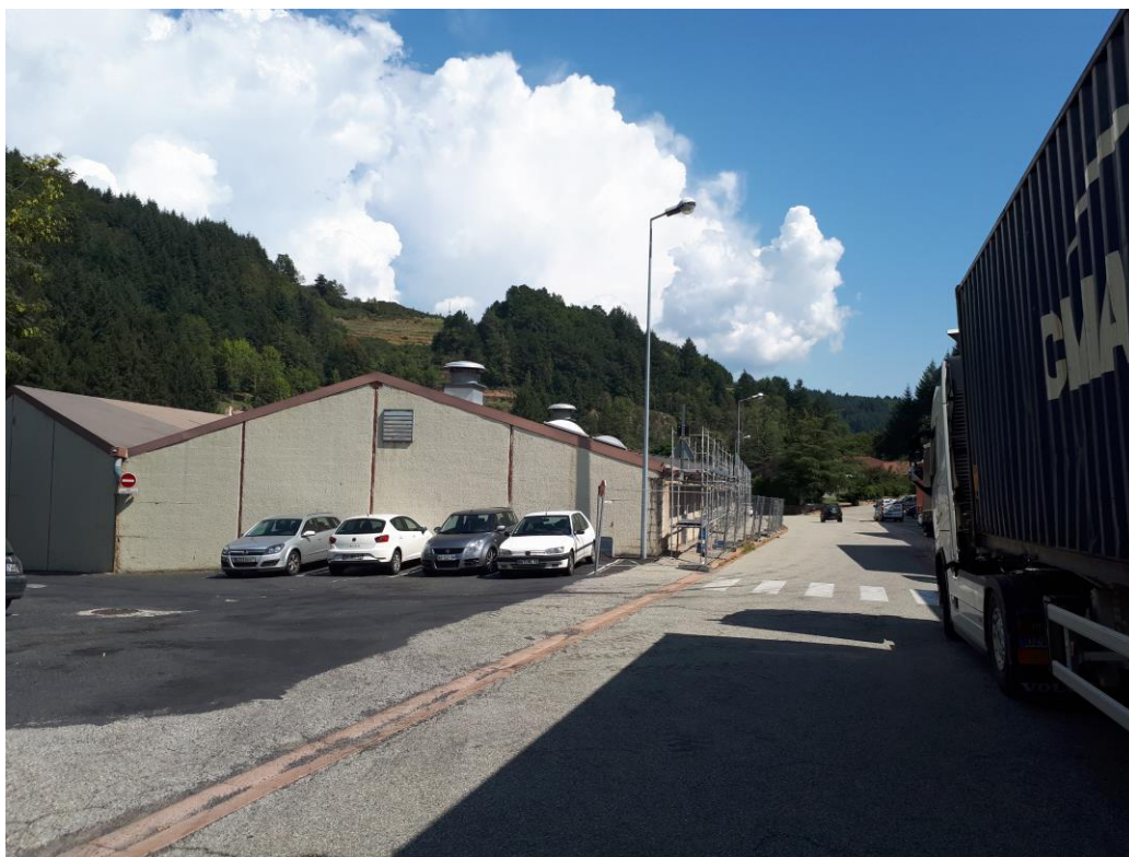
Photo n°1 : vue du bâtiment A depuis D578
