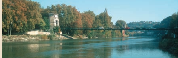
Le pont et le pré de l'île vus depuis l'écluse de Caluire
